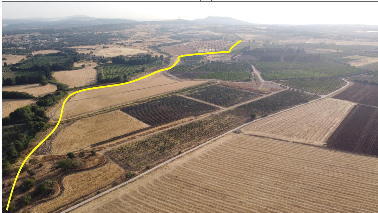
Fig. 26: percorso del cavidotto di collegamento fra il lotto 1 e 2 (tratto su suolo agricolo)
