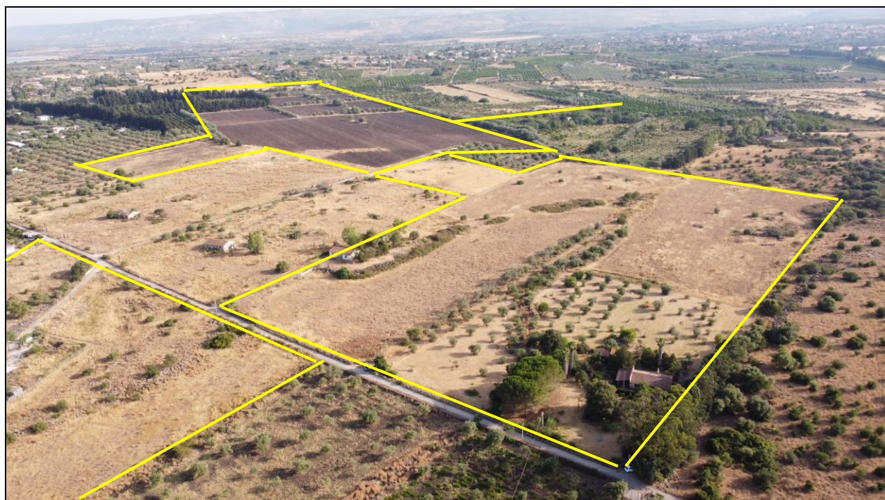
Fig. 27: vista sul lotto 2 (UURR 1, 2, 3, 5) e cavidotto (UR 4)
