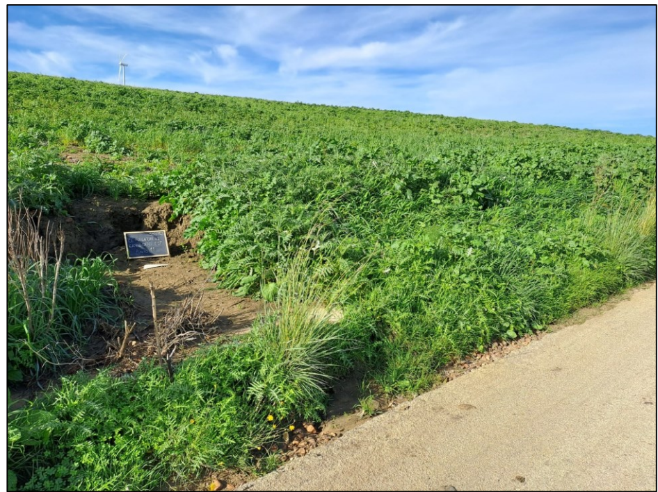
Fig. 37: Cavidotto esterno. Punto 11 – Tratto II
