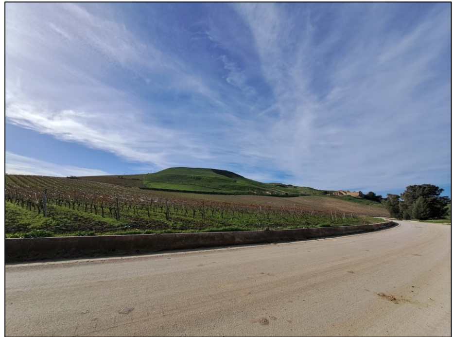
Fig. 42: Cavidotto esterno. Punto 14 – Tratto IV
