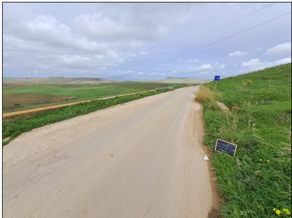
Fig. 27: Cavidotto esterno. Punto 2 – Tratto I
