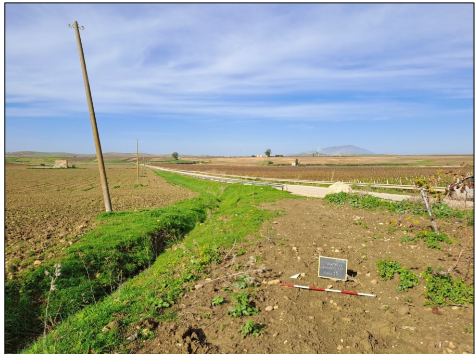
Fig. 43: Cavidotto esterno. Punto 15 – Tratto V
