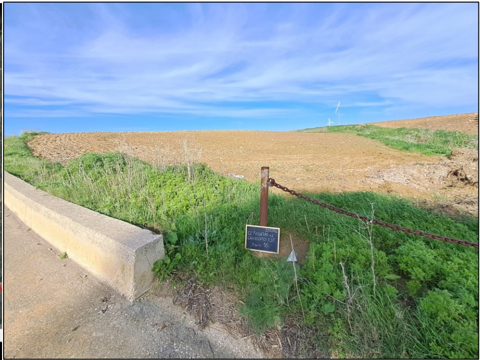
Fig. 44: Cavidotto esterno. Punto 16 – Tratto VI
