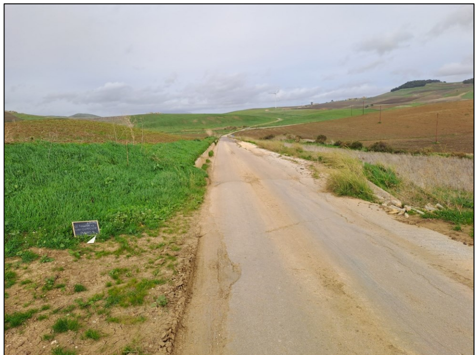
Fig. 33: Cavidotto esterno. Punto 8 – Tratto II
