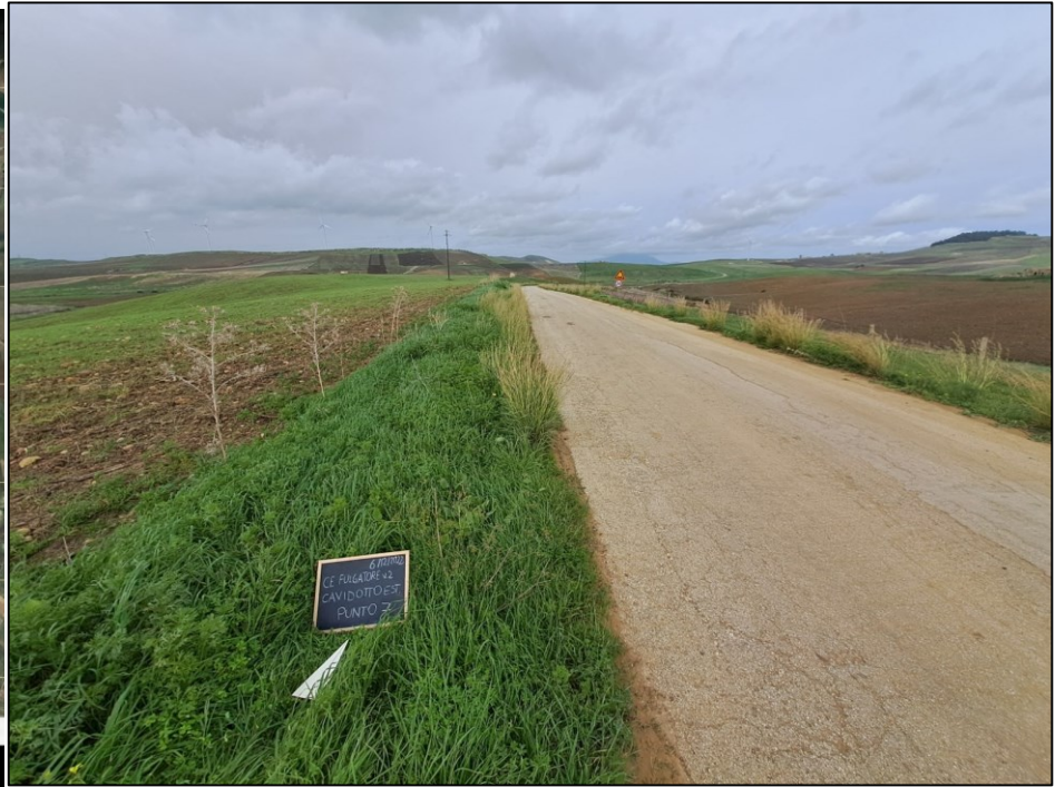
Fig. 32: Cavidotto esterno. Punto 7 – Tratto II
