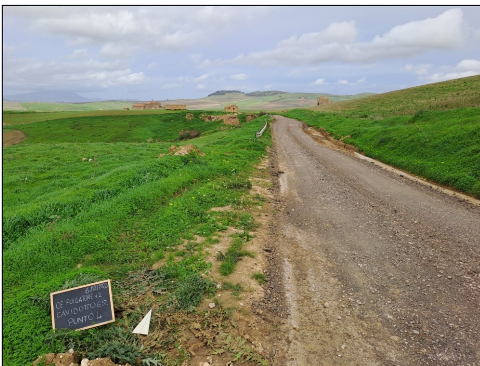
Fig. 29: Cavidotto esterno. Punto 4 – Tratto I
