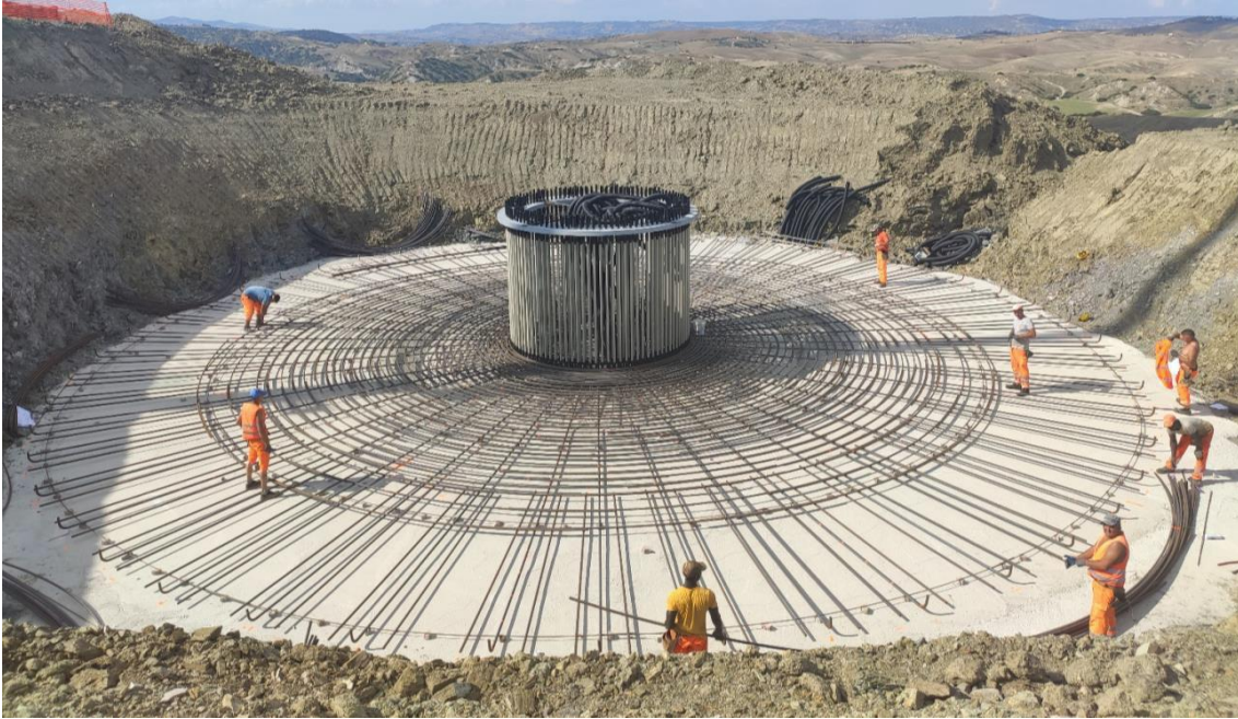
Figura 5: Posa anchor cages tipo
