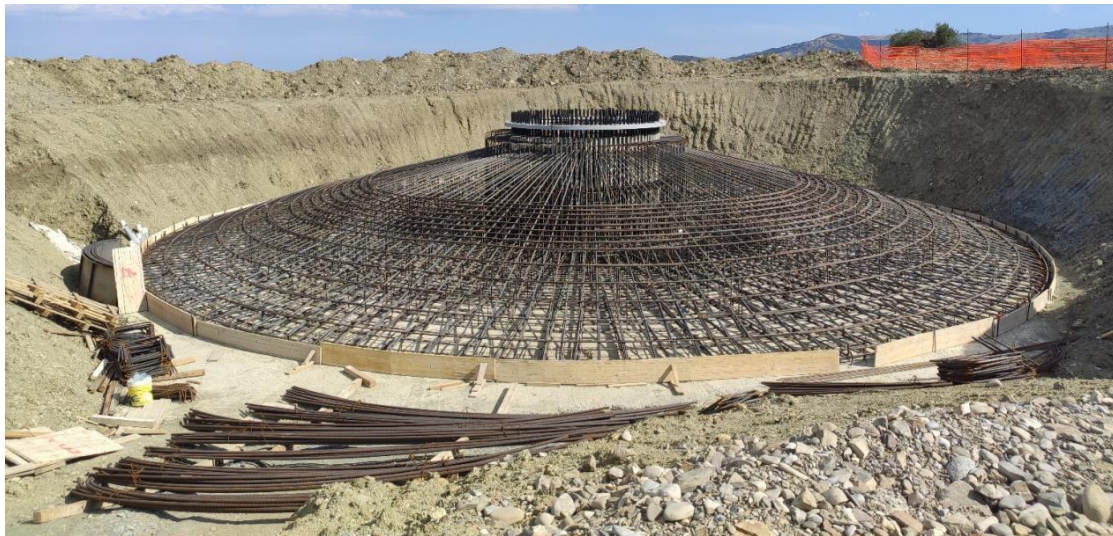
Figura 6: armatura plinto tipo
