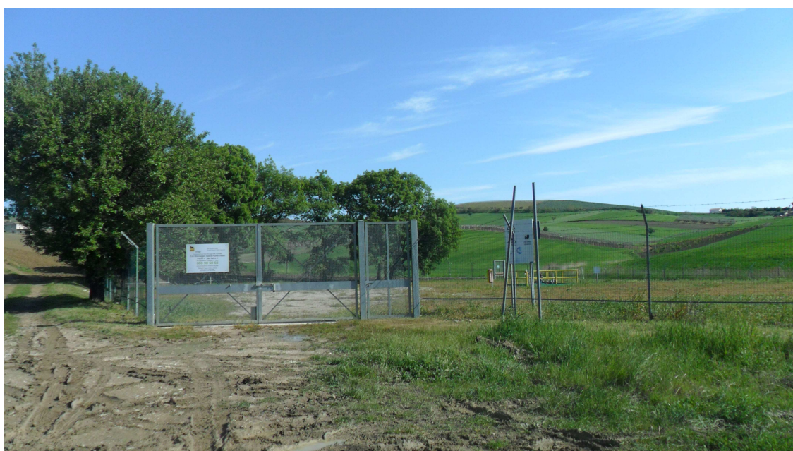
Figura 3.4: Area Pozzo San Salvo 6 vista da Sud
