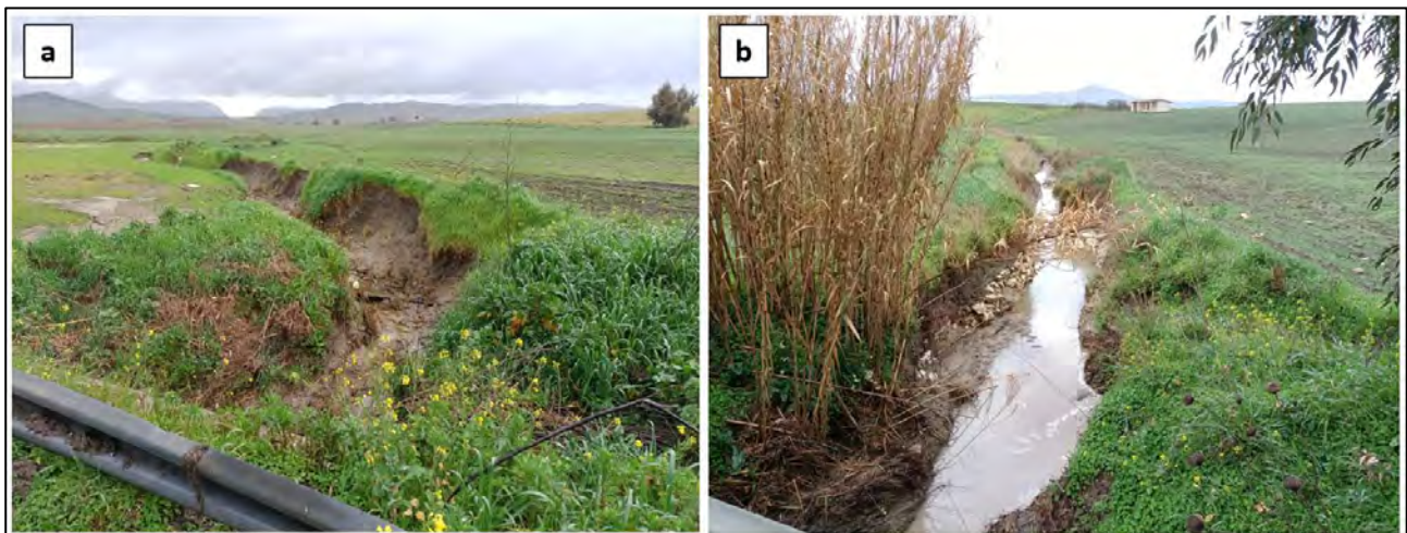
Figura 20: Vista dell'asta fluviale riguardante l'interferenza I.3 verso monte (a) e verso valle (b)
