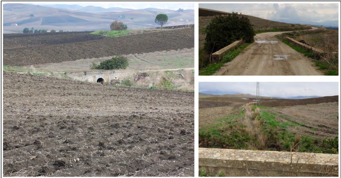
Figura 17: Interferenza I.2 e relativo manufatto rilevato da sopralluogo in sito
