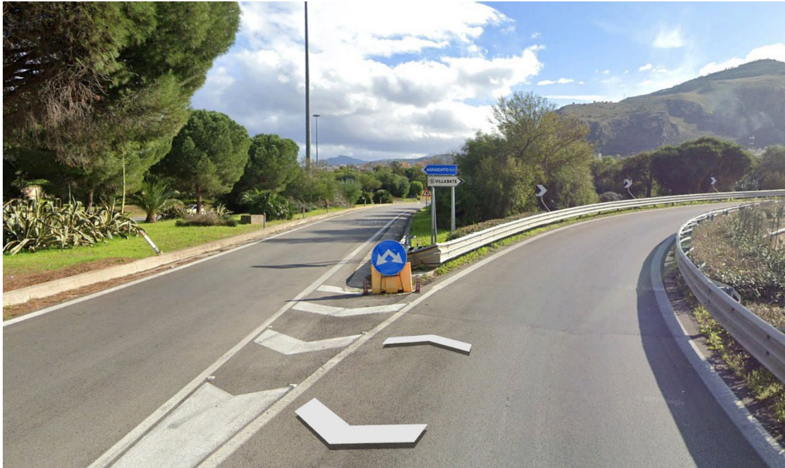
Figura 11 – Punto P2 che rappresenta l'ingresso alla SS 121 Catanese datata 06/2021 (Google Street View)
