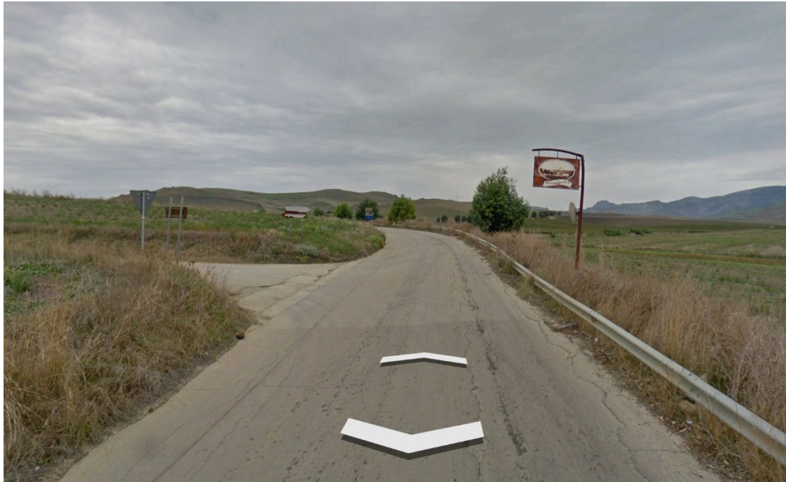
Figura 14 – Punto P5 del tracciato, che rappresenta la SP 4 e l'incrocio da prendere verso l'area di cantiere datata 09/2018 (Google Street View)
