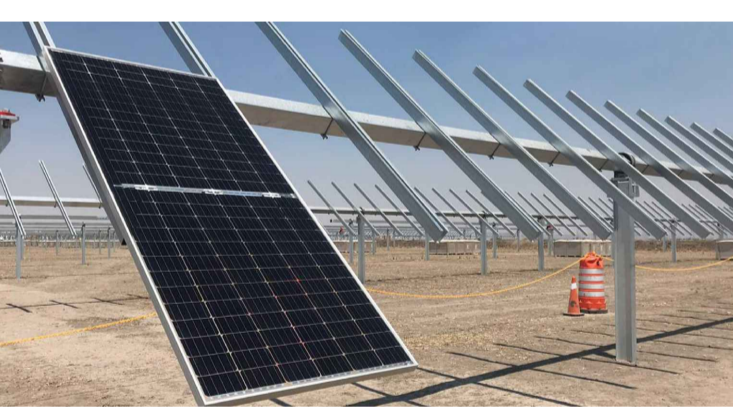
FASE DI MONTAGGIO
