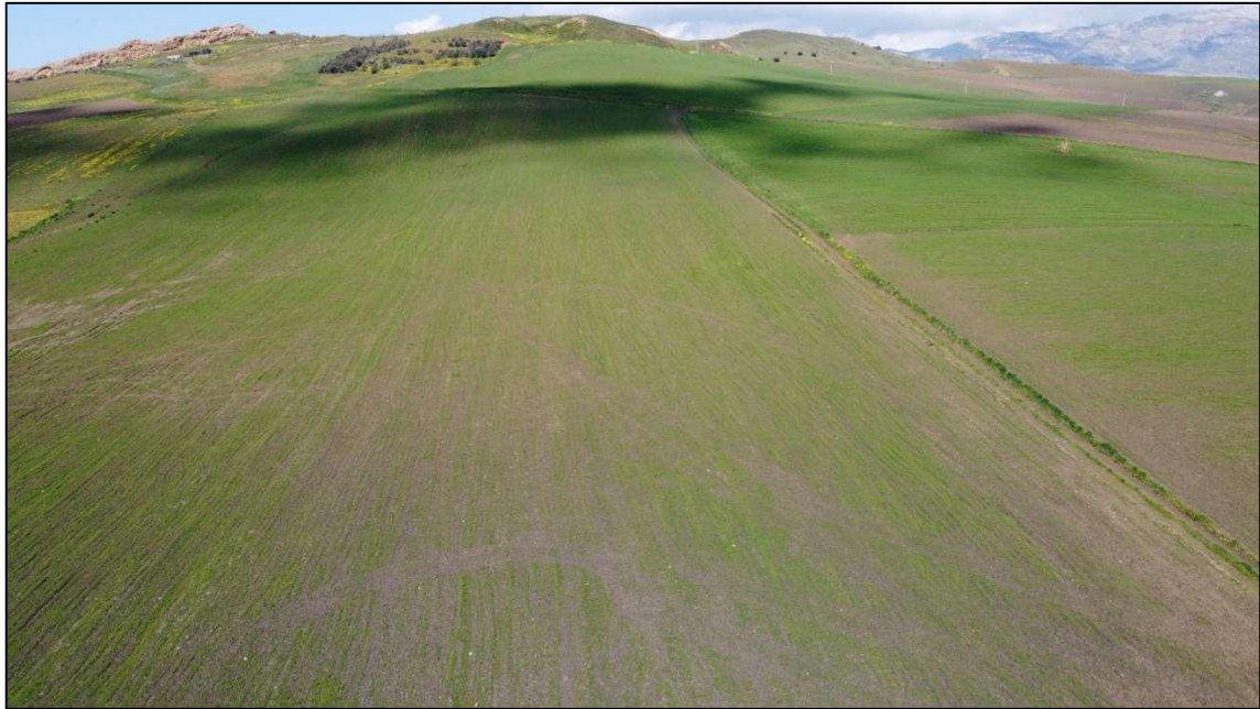
Campo FV – Settore Nord-Ovest (foto da drone)
