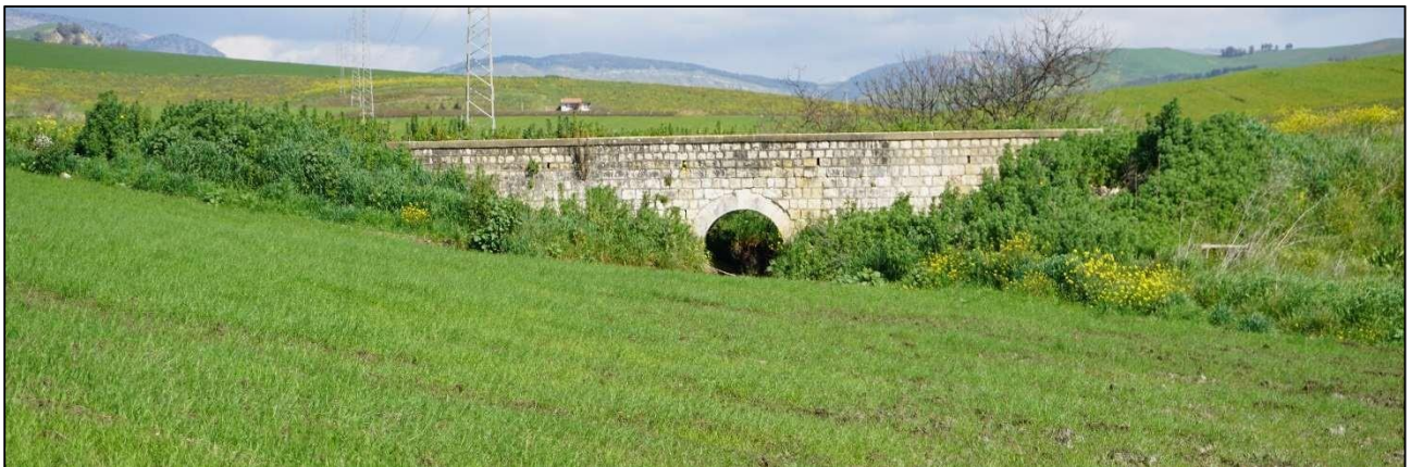
Campo FV – Settore Sud-Ovest – Ponte moderno della SP 91
