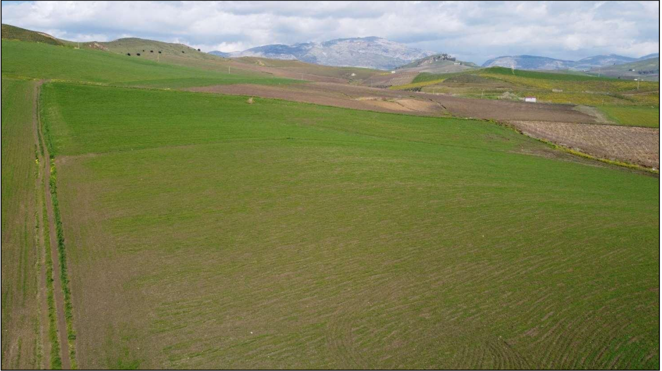
Campo FV – Settore Nord-Est – parte occidentale (foto da drone)
