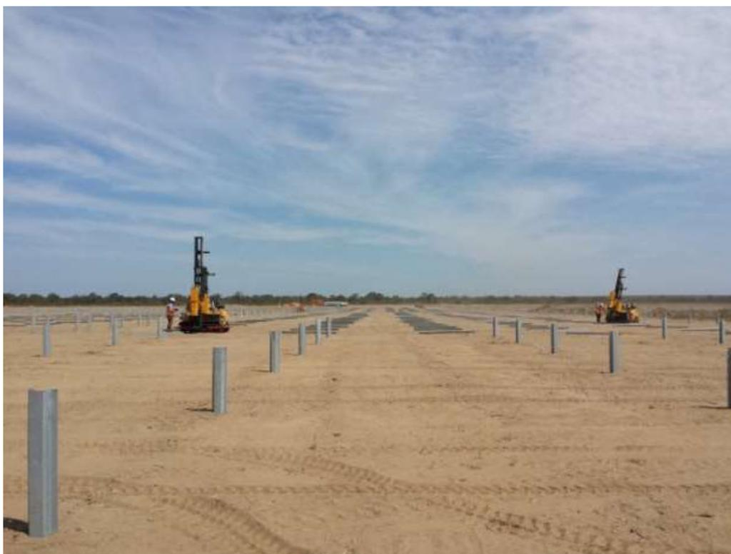
*Figura 16- Esempio di disposizione dei pali di fondazione delle strutture*
