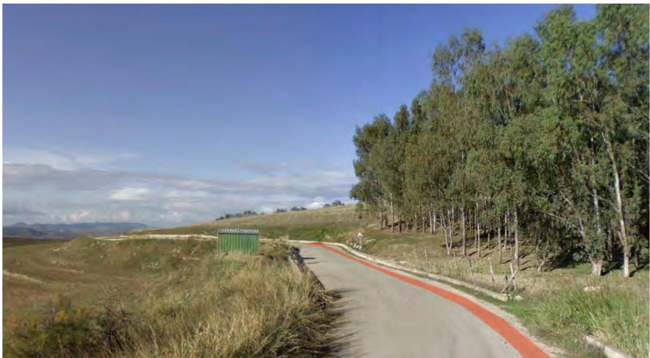
*Figura 55 - INTERFERENZA 5 - la foto mostra in forma schematica, in rosso, il tracciato dello scavo per la posa in opera del cavidotto. Al margine della strada è visibile un rimboscimento di eucalipto. Lo scavo non danneggia la vegetazione esistente e fine lavori sarà ripristinato totalmente lo stato dei luoghi, pertanto l'effetto percettivo finale dell'intervento sarà di totale invisibilità.*
