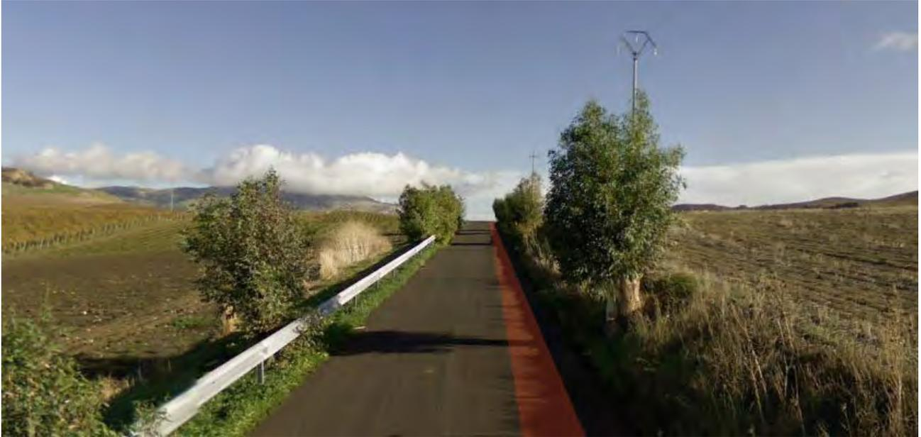
*Figura 58 - La foto mostra la simulazione della tipologia di attraversamento tipo del cavidotto, interrato sulla sede stradale asfaltata della SP 92, classificata come trazzera.*
