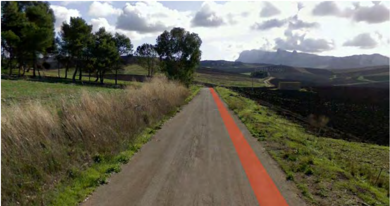
Figura 76 - Interventi tipologico per lo scavo del cavidotto su trazzera reintegrata su SP 42
