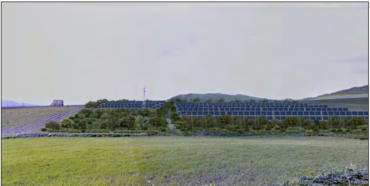
FS. 2 POST OPERAM- La foto mostra l'impianto agro-voltaico in esercizio, con le fasce di mitigazione suggerite dalla vegetazione spontanea di margine
