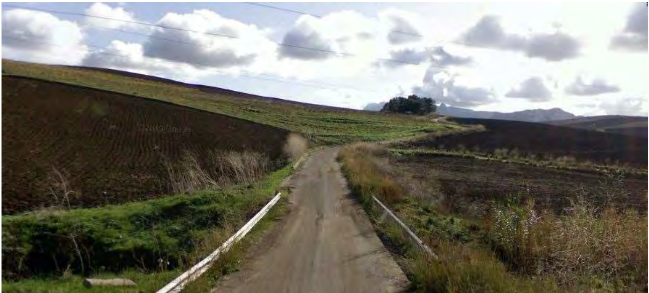
Figura 65 - Nella foto il punto di attraversamento sul Vallone dell'Aquila
