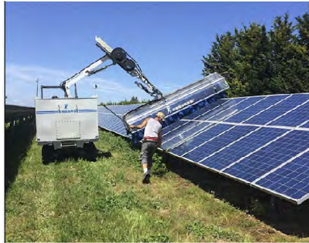
Figura 44 - Pulizia meccanizzata dei pannelli
