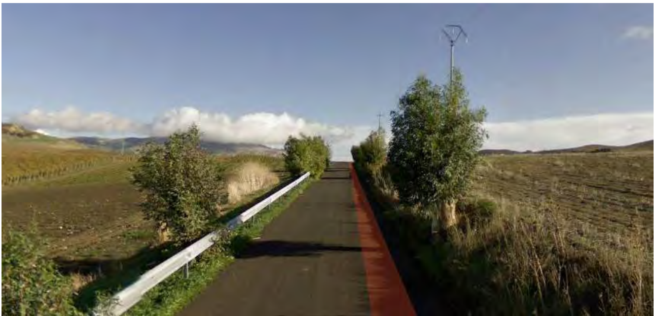
Figura 75 - La foto mostra la simulazione della tipologia di attraversamento tipo del cavidotto, interrato sulla sede stradale asfaltata della SP 92, classificata come trazzera.
