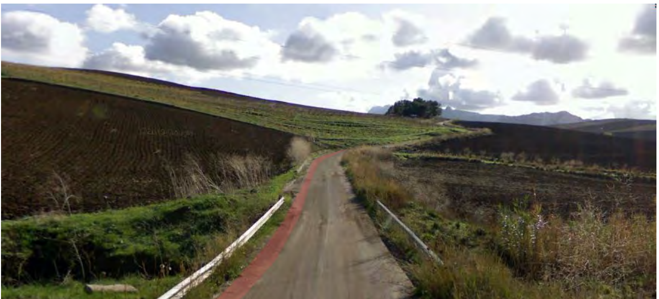
Figura 47 – Nella foto il punto di attraversamento sul Vallone dell' Aquila,
