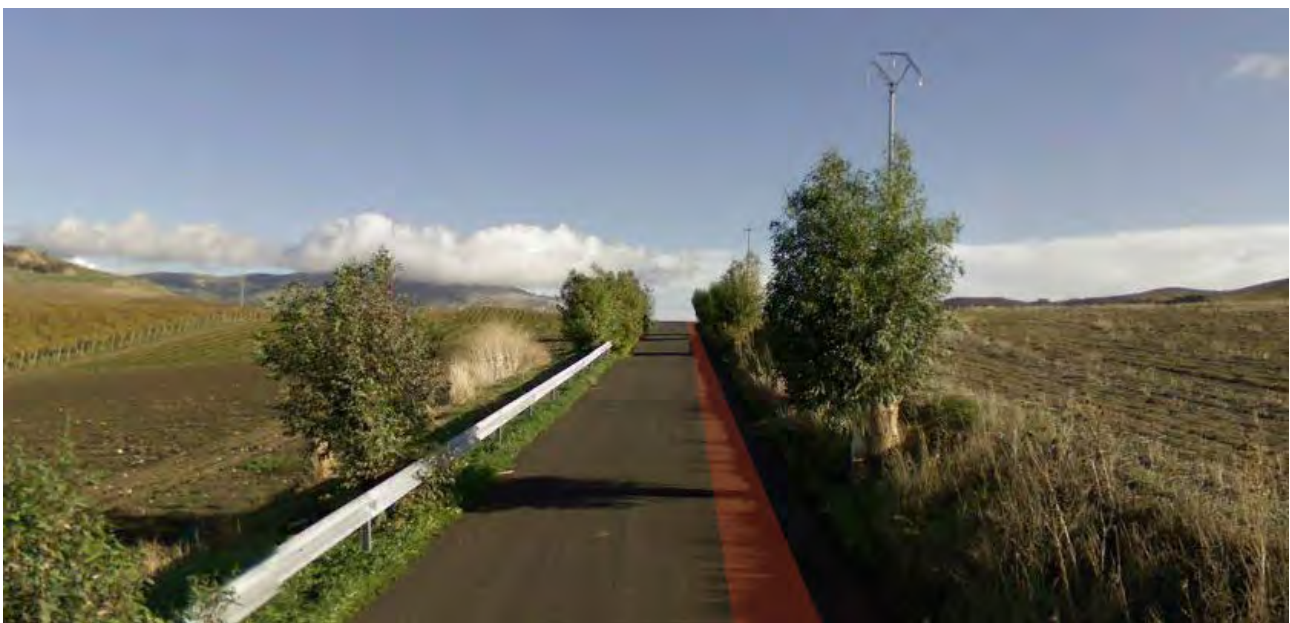
Figura 57 – La foto mostra la simulazione della tipologia di attraversamento tipo del cavidotto, interrato sulla sede stradale asfaltata della SP 92, classificata come trazzera.
