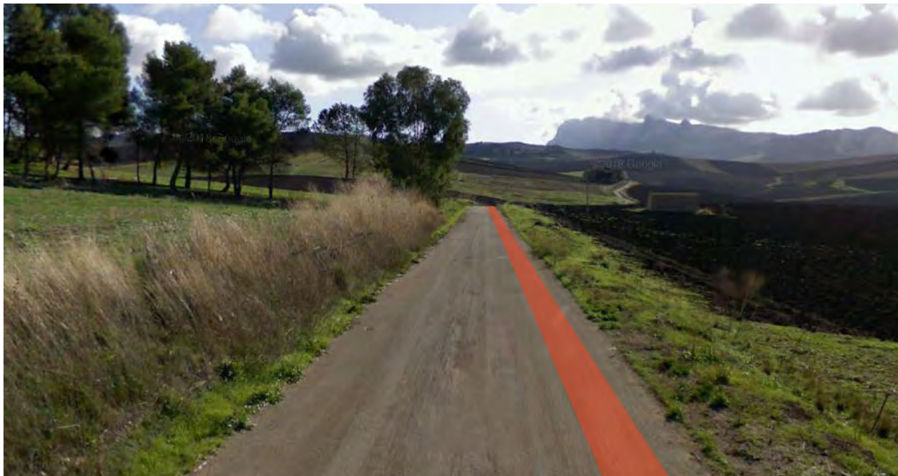
Figura 58 . Interventi tipologico per lo scavo del cavidotto su trazzera reintegrata su SP 42
