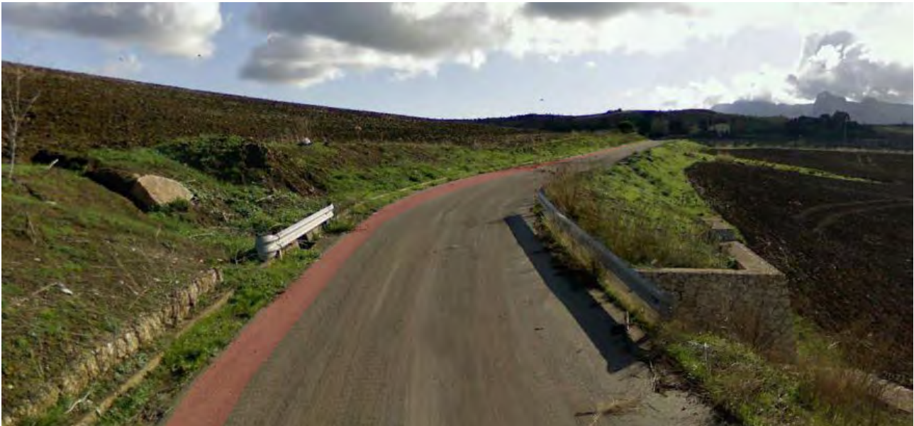
Figura 50 - Nella foto il punto di attraversamento del cavidotto lungo la SAP 42, in rosso la simulazione dello scavo tipo per la posa in opera del cavidotto.
