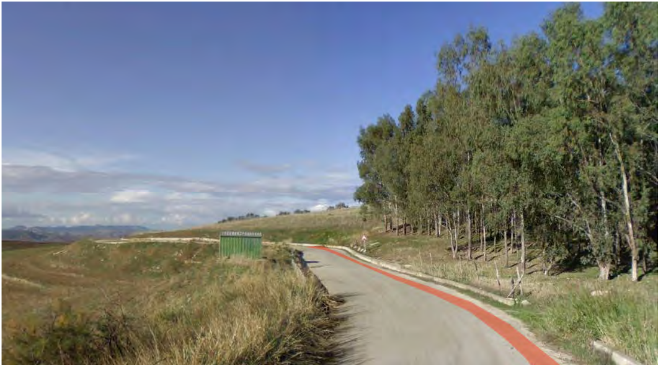
Figura 54 –INTERFERENZA 5 - la foto mostra in forma schematica, in rosso, il tracciato dello scavo per la posa in opera del cavidotto. Al margine della strada è visibile un rimboscimento di eucalipto. Lo scavo non danneggia la vegetazione esistente e fine lavori sarà ripristinato totalmente lo stato dei luoghi, pertanto l'effetto percettivo finale dell'intervento sarà di totale invisibilità.
