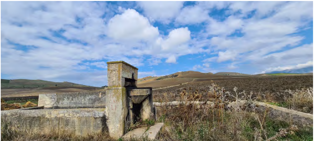
Figura 10 – Gebbia novecentesca ubicata al centro dell'area d'impianto, adiacente alla SP 91, sullo sfondo Il paesaggio agrario del sito, con la continuità dei campi coltivati a seminativo
