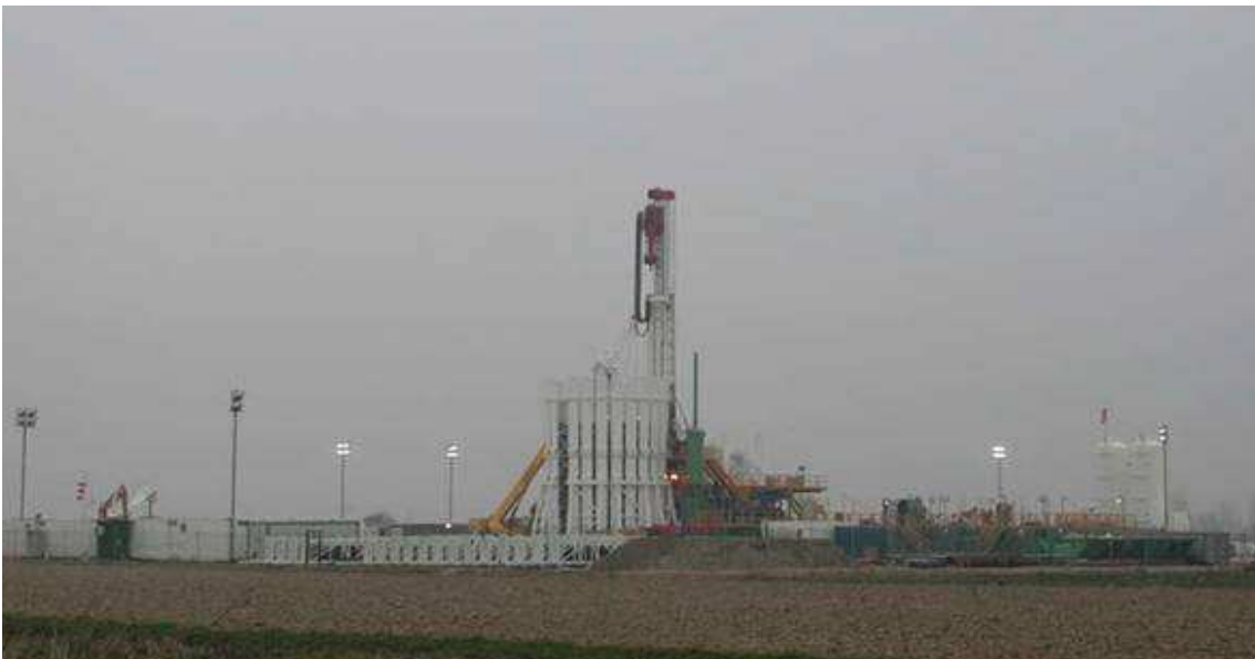
Figura 4-2: Impianto di perforazione HH "Archimede"
