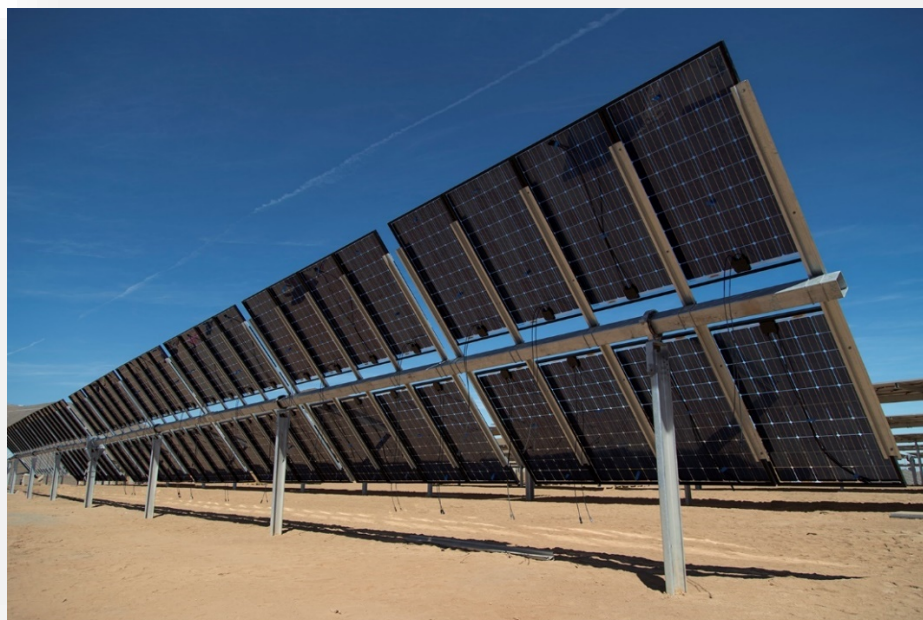
Figura 1 – vista prospettica inseguitore solare monoassiale
