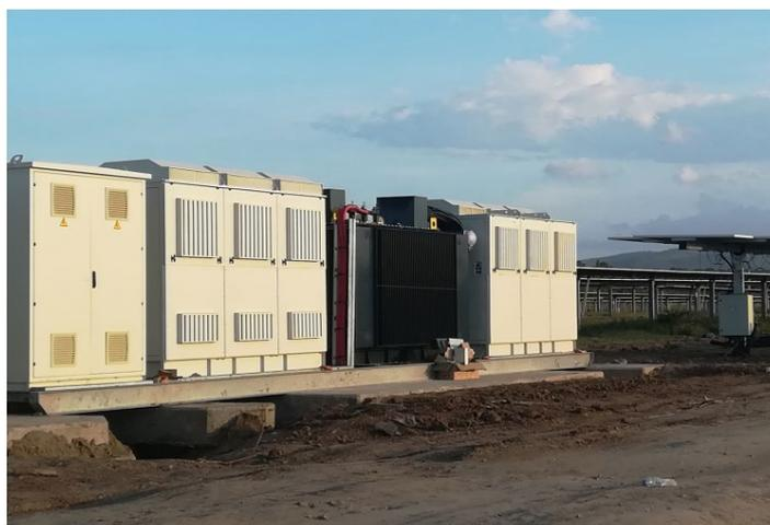
**Figura 10 Esempio skid conversione**
