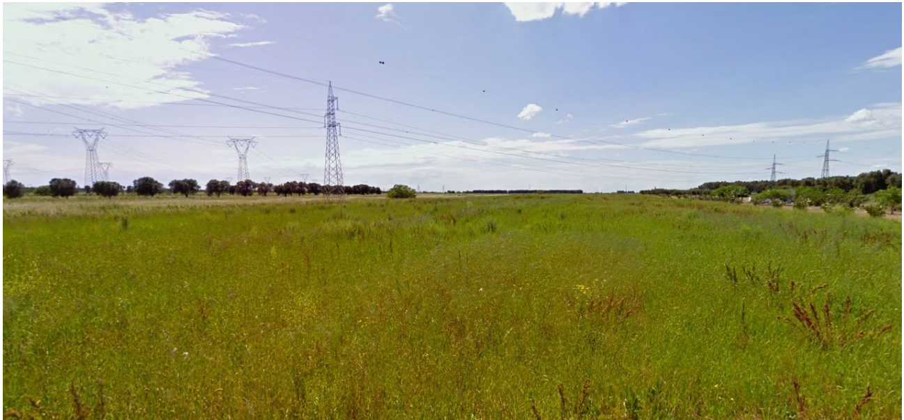
FIGURA 7 – Vista panoramica scattata dalla Strada per Marfeo verso ovest del sito d'intervento (fonte: Google Maps)
