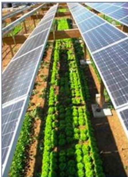
Nel layout dell'impianto si è optato per il perfetto allineamento di tutti i tracker di ogni fila, andando a distanziare le file in maniera opportuna; in tal modo è stato possibile riutilizzare la maggior quantità di terreno a fini agricoli senza produrre un aumento globale della superficie occupata dall'impianto (rispetto ad un impianto tradizionale a terra).
