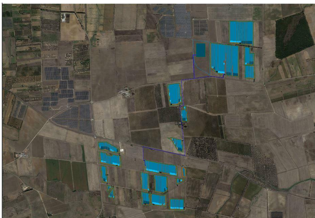
Figura 1-LUCERA-stralcio fotogrammetrico con il campo fotovoltaico
