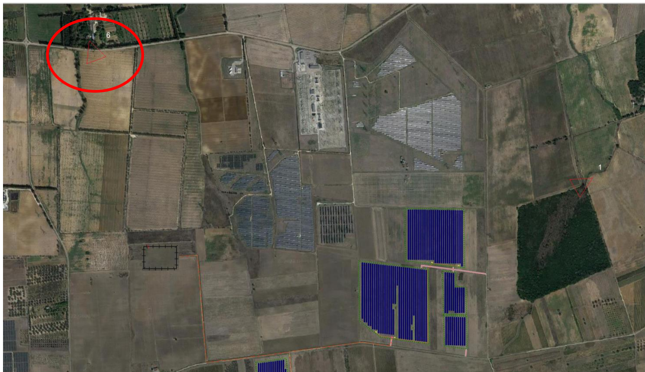
Fig. 3.23. Inquadramento punto di presa 6.
