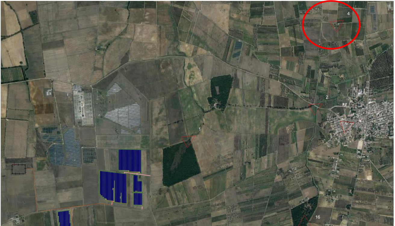
Fig. 3.15. Inquadramento punto di presa 4.
