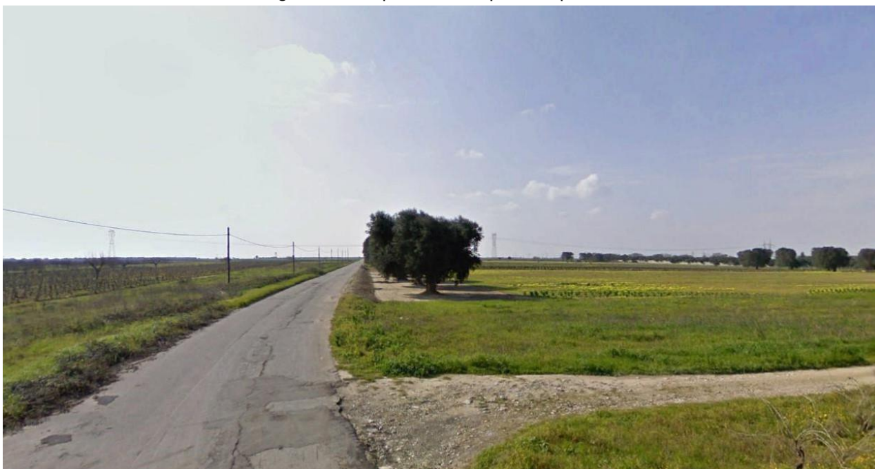
Figura 3.4. – Punto di presa 1. Stato di fatto.
