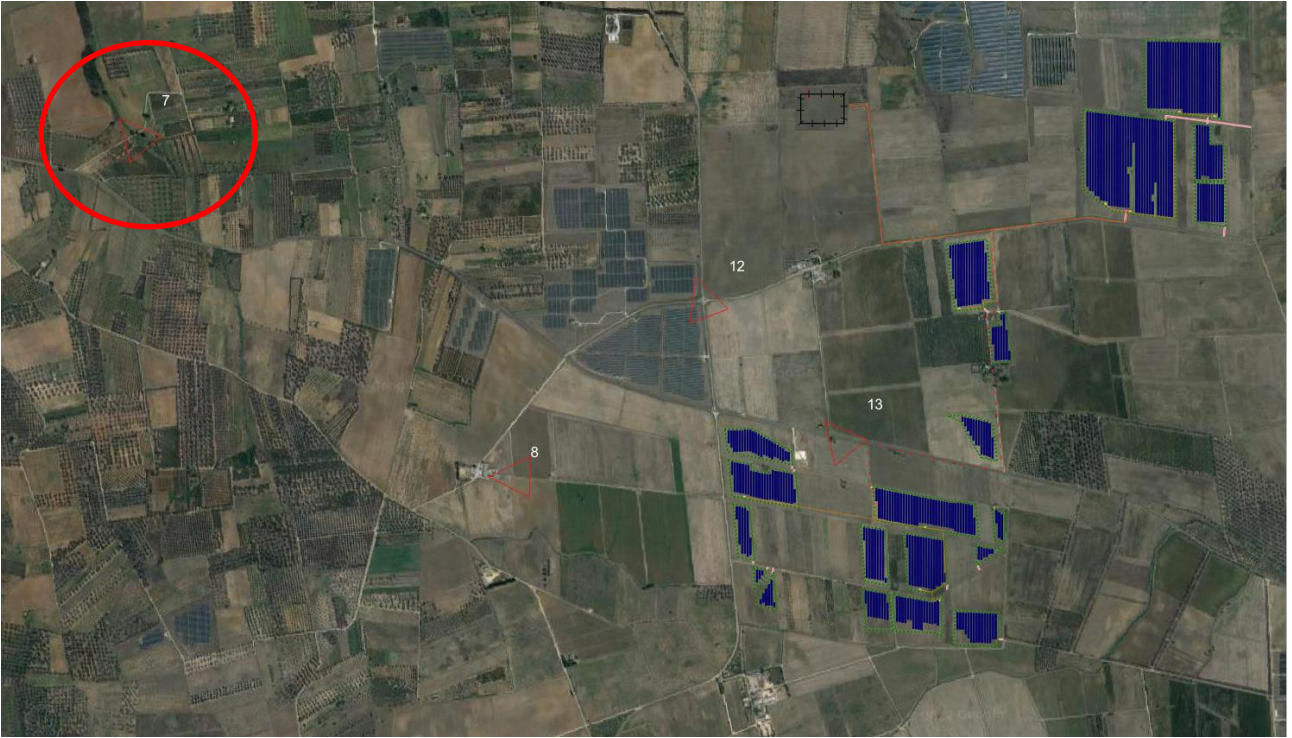
Fig. 3.27. Inquadramento punto di presa 7.
