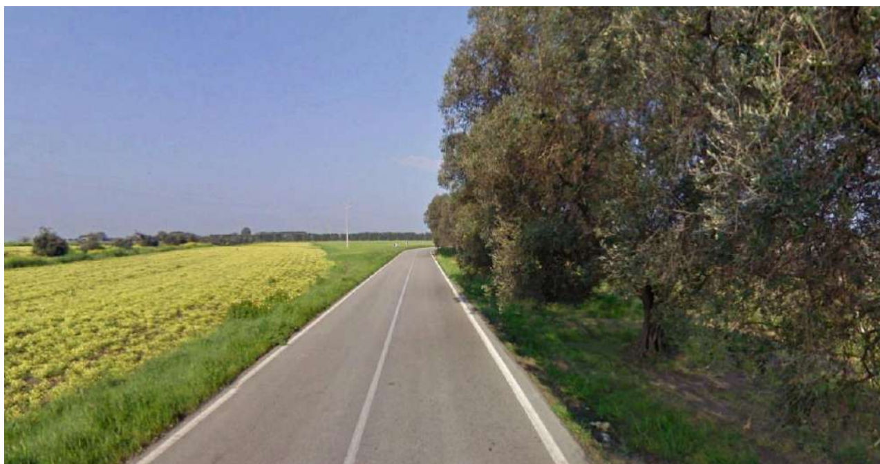
Fig. 7.6.56. Punto di presa 14. Stato di fatto.
