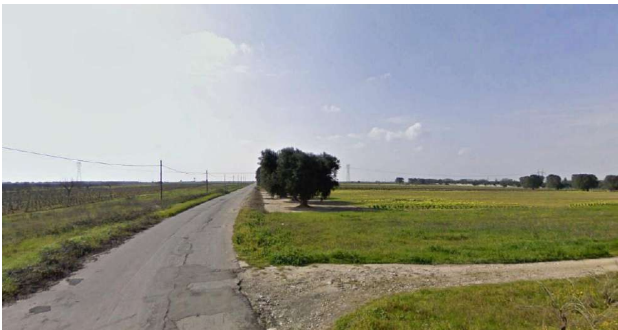
Figura 7.6.4. – Punto di presa 1. Stato di fatto.
