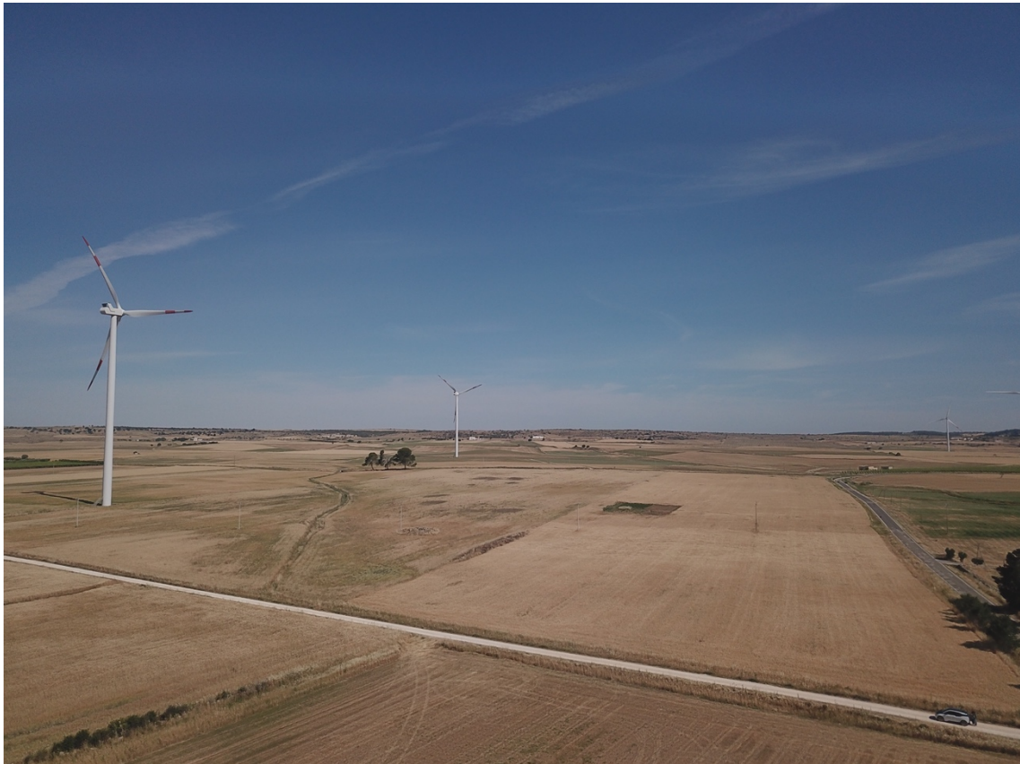
Rilievo fotografico aree con drone – Sud-est
