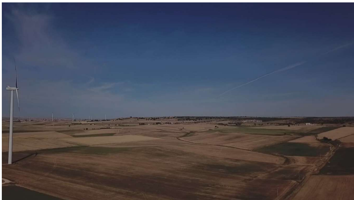
Figura 7 - Rilievo fotografico aree con drone - est.
