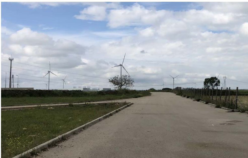
Figura 1097: Vista dal punto 4 post operam, dove sorgerà la stazione di elevazione affianco alla S.E. Terna di Castellaneta
