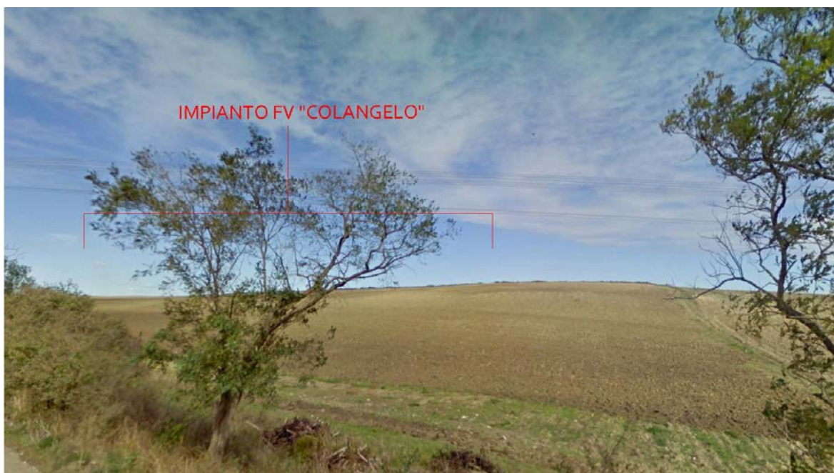
Figura 36: Vista prospettica dell'impianto da Masseria Delle Monache
