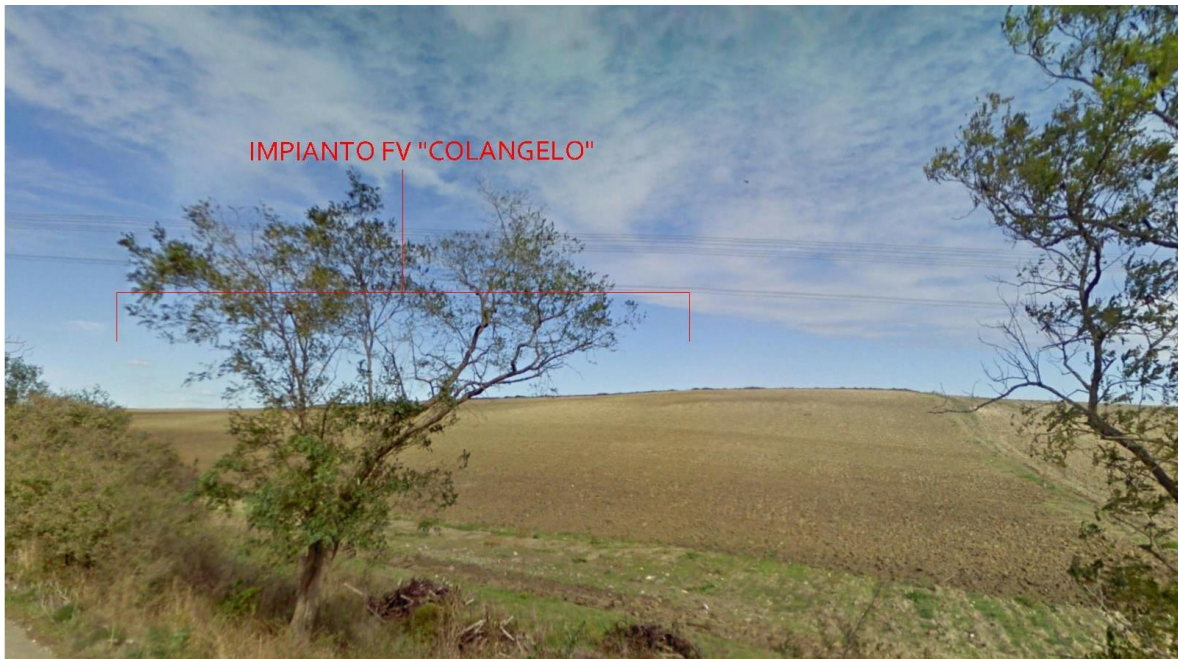
Figure 35: Vista prospettica dell'impianto da Masseria Delle Monache
