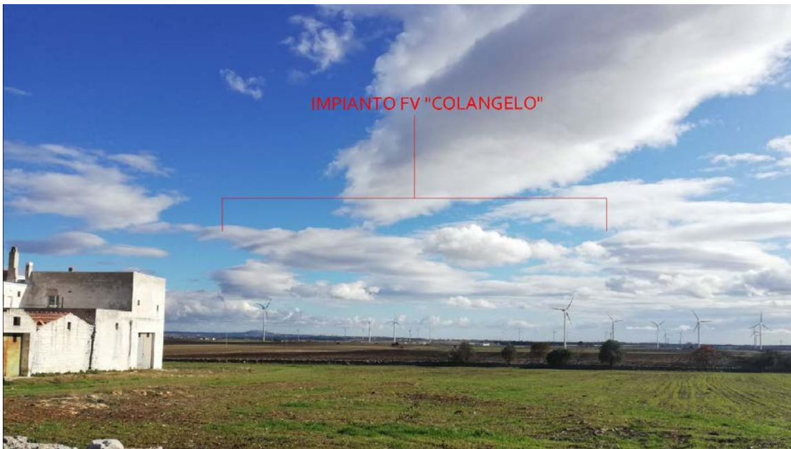
Figura 46: Vista prospettica dell'impianto da Masseria Facce Rosse
