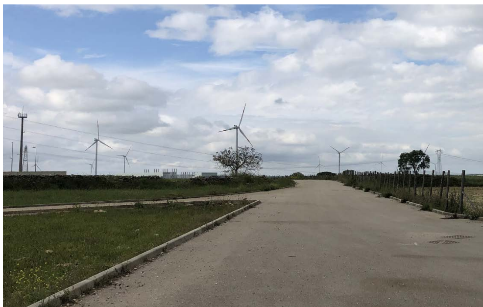
Figura 13910: Vista dal punto 4 post operam, dove sorgerà la stazione di elevazione affianco alla S.E. Terna di Castellaneta
