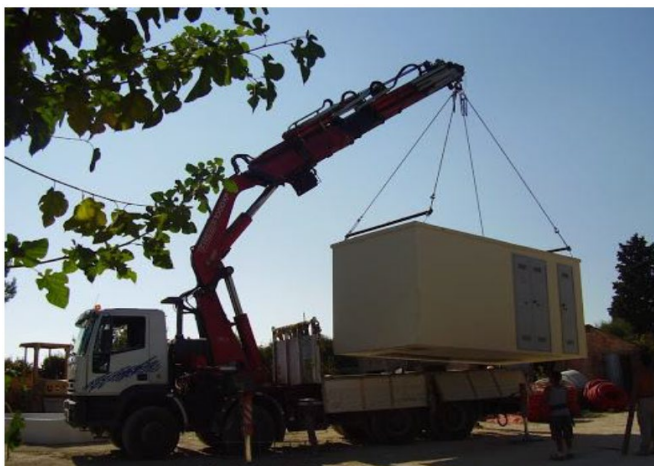
Figura 42: Fornitura e posa in opera delle cabine di raccolta e delle Power Station
