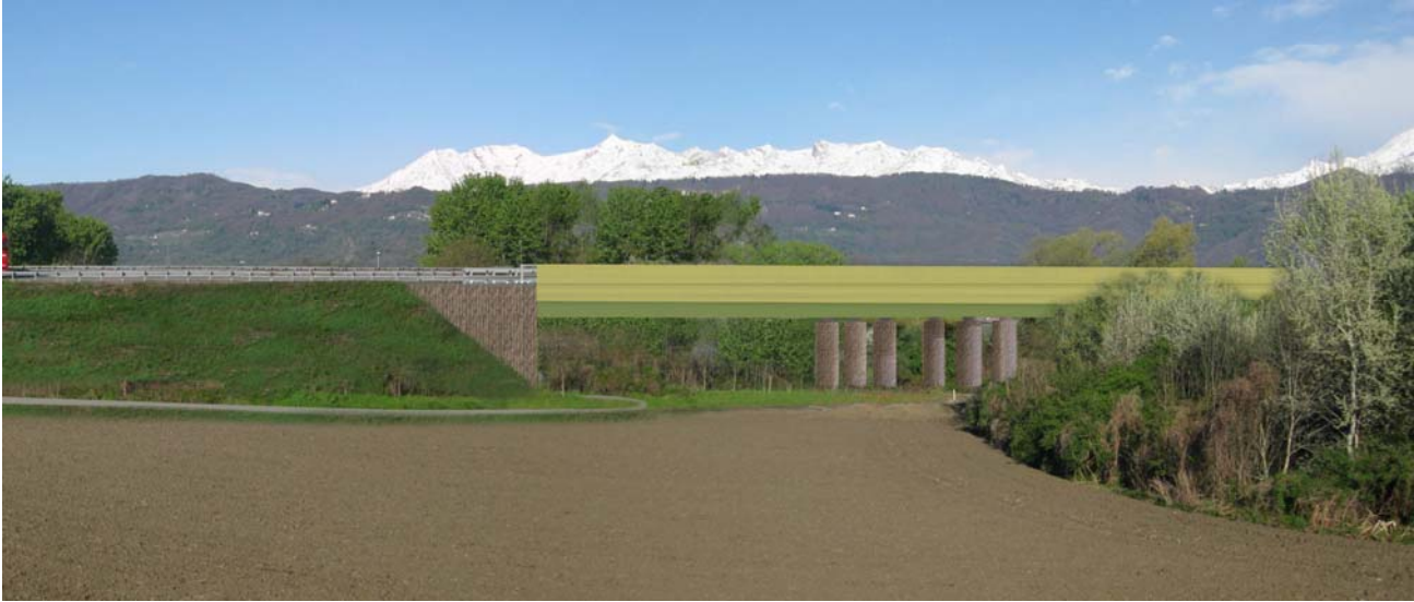
Figura 2.3.2/8 Foto inserimento (punto di ripresa 1 in figura 2.3.2/2 - Trattamento cromatico delle travi e della veletta e trattamento della superficie delle spalle e delle pile. Il fotoinserimento riproduce la situazione senza interventi di sistemazione a verde.
