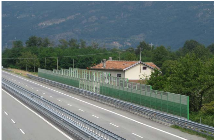
Figura 1.2.5/12 Barriera antirumore realizzata lungo la A5 in corrispondenza dell'area critica di Borgofranco
