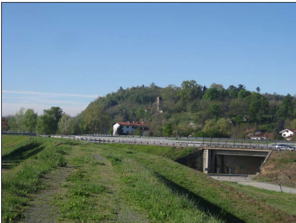
Figura 2.3.2/3 Foto 1 - L'argine che si interpone tra l'abitato di Banchette e il tratto autostradale in cui si colloca il viadotto
