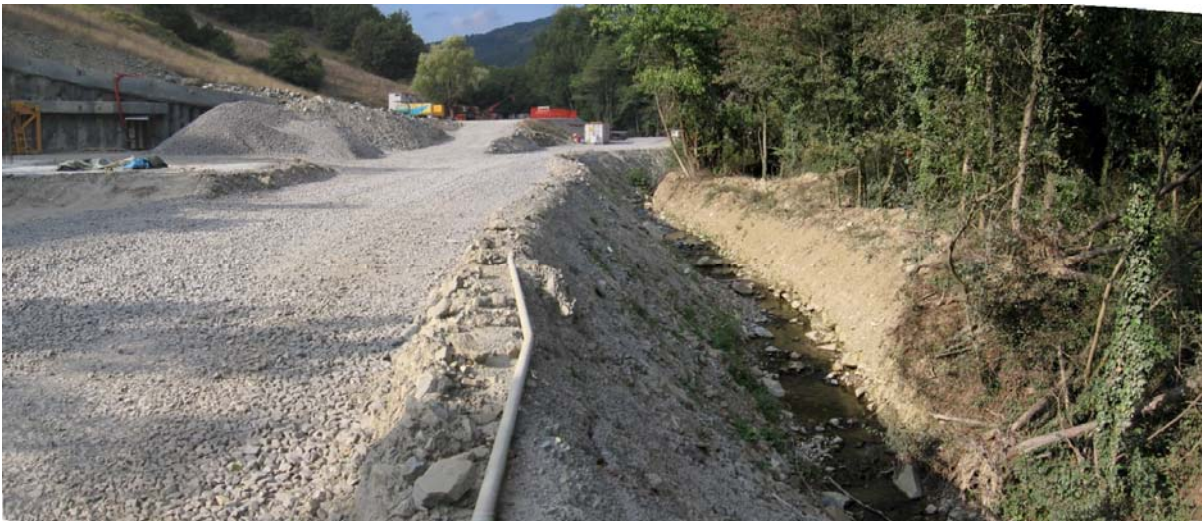
Figura 1.3.4.2/1 Arginello di contenimento delle acque di dilavamento delle aree di cantiere in un tratto di affiancamento a un corso d'acqua
