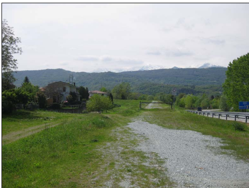
Figura 2.3.2/4 Foto 2 - L'argine che si interpone tra l'abitato di Salerano e il tratto autostradale in cui si colloca il viadotto, che risulta localizzato sulla destra oltre le zone alberate
