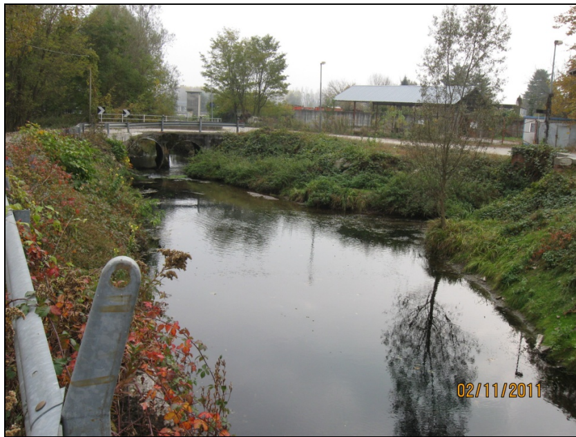
Figura 1.2.2/4 – Ponte provvisorio visto dal sito del ponte originario.
