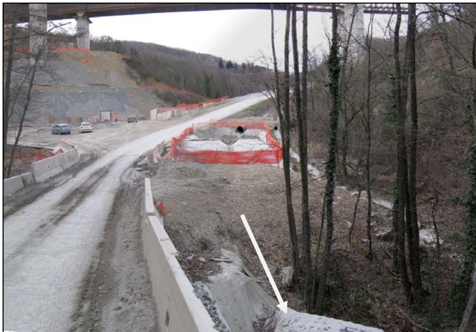
Figura 1.3.4.2/3 Vasca di intercettazione/decantazione realizzata in linea sul collettore di drenaggio delle aree di cantiere: le acque portate dalla tubazione vengono immesse in una prima vasca di decantazione da cui fuoriescono per sfioro superficiale e vengono riprese dalla condotta e indirizzate al recapito su un corso d'acqua (il punto di recapito è indicato dalla freccia in primo piano). Parallelamente alla linea di collettamento delle acque di cantiere è stata predisposta una canaletta di raccolta delle acque di versante (a destra nella foto), che vengono raccolte e accompagnate al recapito evitando qualsiasi contatto con le acque di cantiere.
