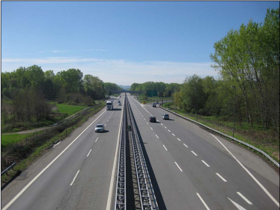
Figura 1.1.1/12 Diffusa presenza di vegetazione boschiva e ripariale nell'intorno dell'area del viadotto Cartiera. Questo aspetto, unitamente ai vincoli connessi all'esigenza di realizzare il viadotto mantenendo il traffico, con restrizioni e deviazioni, lungo l'asse autostradale, impone di limitare l'occupazione di aree nella fase di cantiere, condizionando di conseguenza la scelta della specifica tipologia ad arco.
