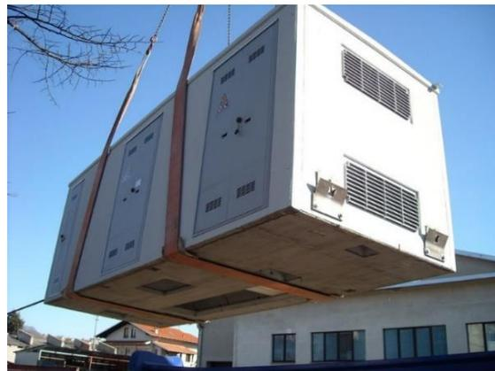
Figura 3: Rimozione delle cabine di raccolta e delle Power Station
