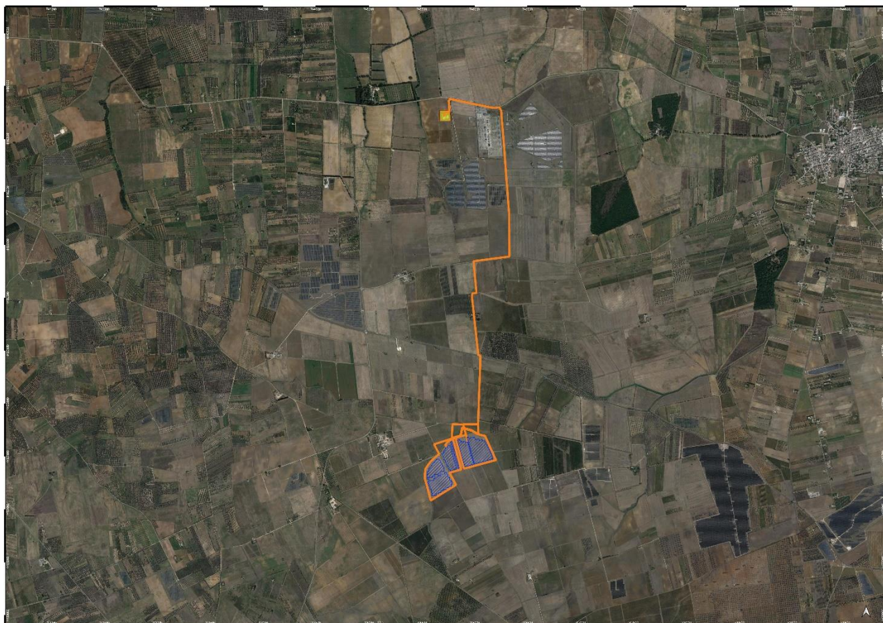
Figura 4: Foto aerea con indicazione dell'area di impianto oggetto di valutazione (fonte Google Earth)
