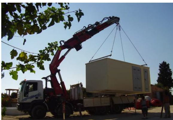
Figura 43: Fornitura e posa in opera delle cabine di raccolta e delle Power Station
