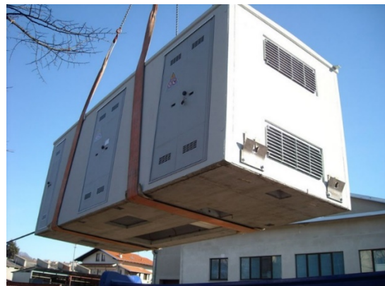
Figura 43: Fornitura e posa in opera delle cabine di raccolta e delle Power Station
