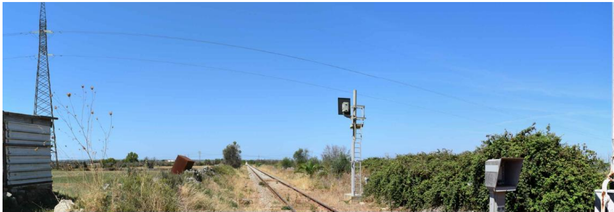
Figura 10 –passaggio del collegamento MT dell’impianto di rete in corrispondenza della linea Ferroviaria
