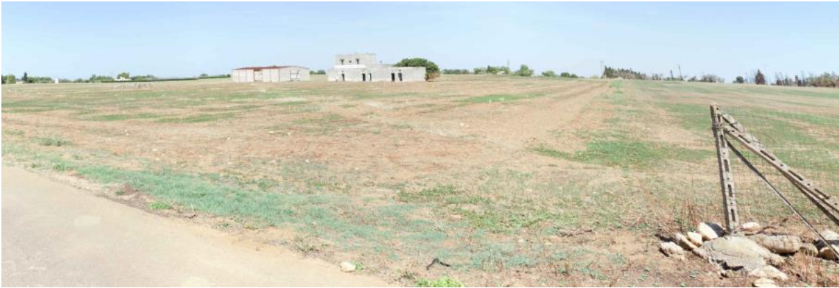
Figura 5 – vista dell'area di impianto (lotto ovest) dallo spigolo sud est
