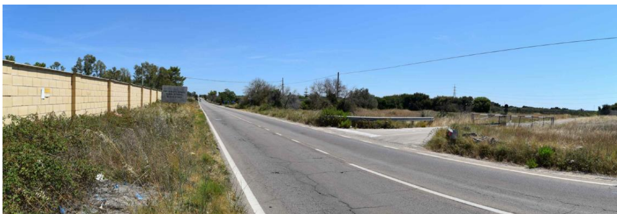
Figura 12 – panoramica della SP 47 interessata dalla posa del collegamento MT dell’impianto di rete, in prossimità dell’ingresso nella CP “Collemeto” esistente.
