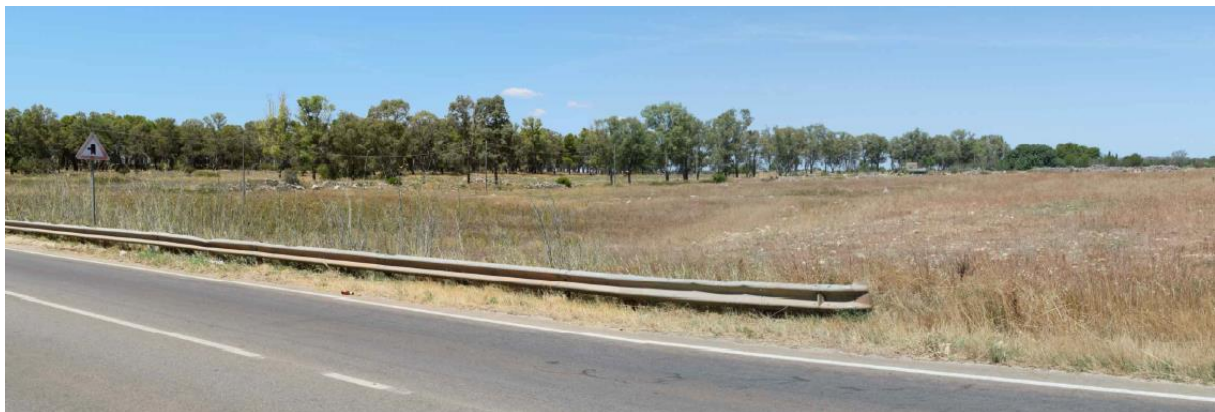
Figura 11 – vista dell’area interessata dal passaggio del collegamento MT aereo dell’impianto di rete – panoramica dalla SP 47
