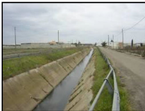
Il Canale Asso a valle dell'abitato di Nardò (LE).
