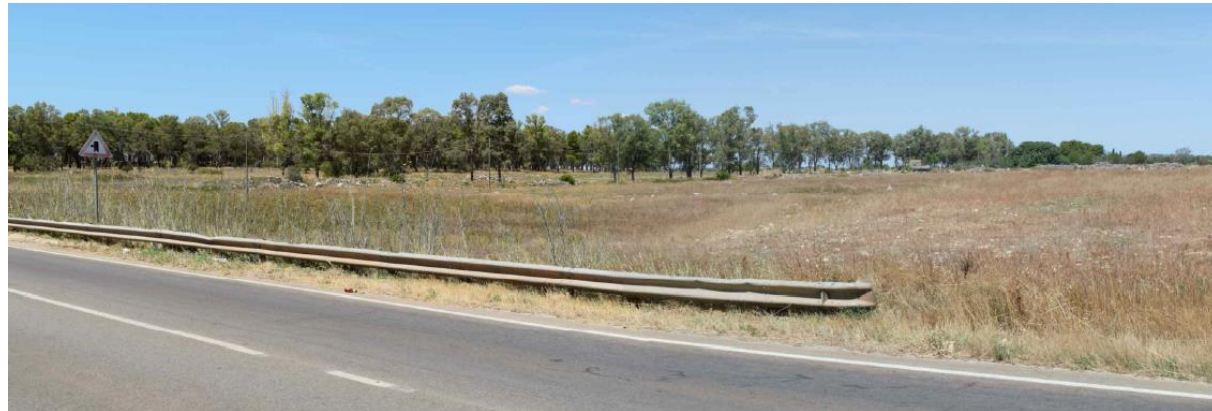
Figura 7 – vista dell'area interessata dal passaggio del collegamento MT aereo dell'impianto di rete – panoramica dalla SP 47
