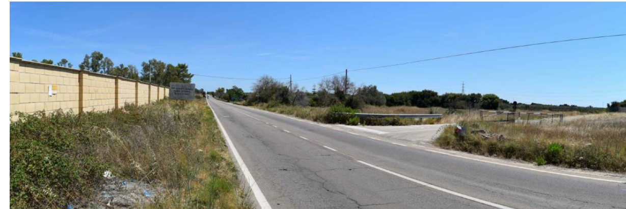
Figura 8 – panoramica della SP 47 interessata dalla posa del collegamento MT dell'impianto di rete, in prossimità dell'ingresso nella CP "Collemeto" esistente.
