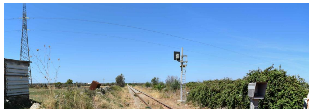
Figura 6 –passaggio del collegamento MT dell'impianto di rete in corrispondenza della linea Ferroviaria
