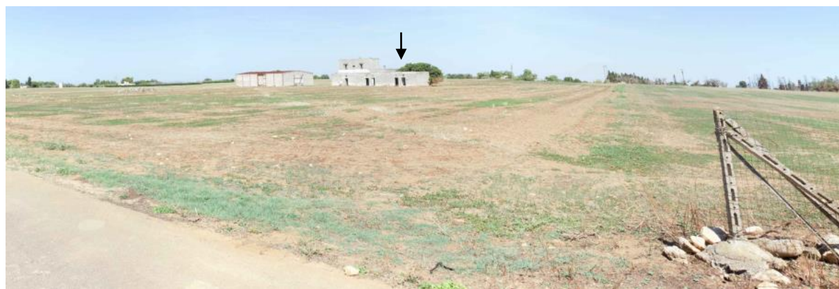
Figura 1 – vista dell'area di impianto (lotto ovest) dallo spigolo sud est
