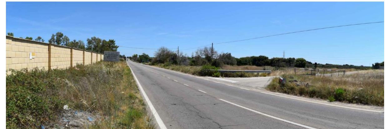
Figura 9 – panoramica della SP 47 interessata dalla posa del collegamento MT dell'impianto di rete, in prossimità dell'ingresso nella CP "Collemeto" esistente.
