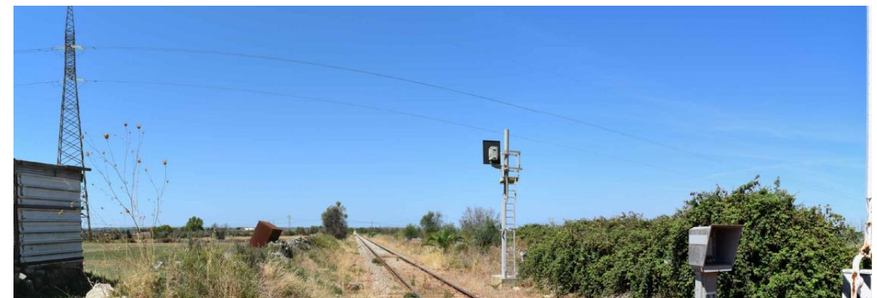
Figura 7 –passaggio del collegamento MT dell'impianto di rete in corrispondenza della linea Ferroviaria
