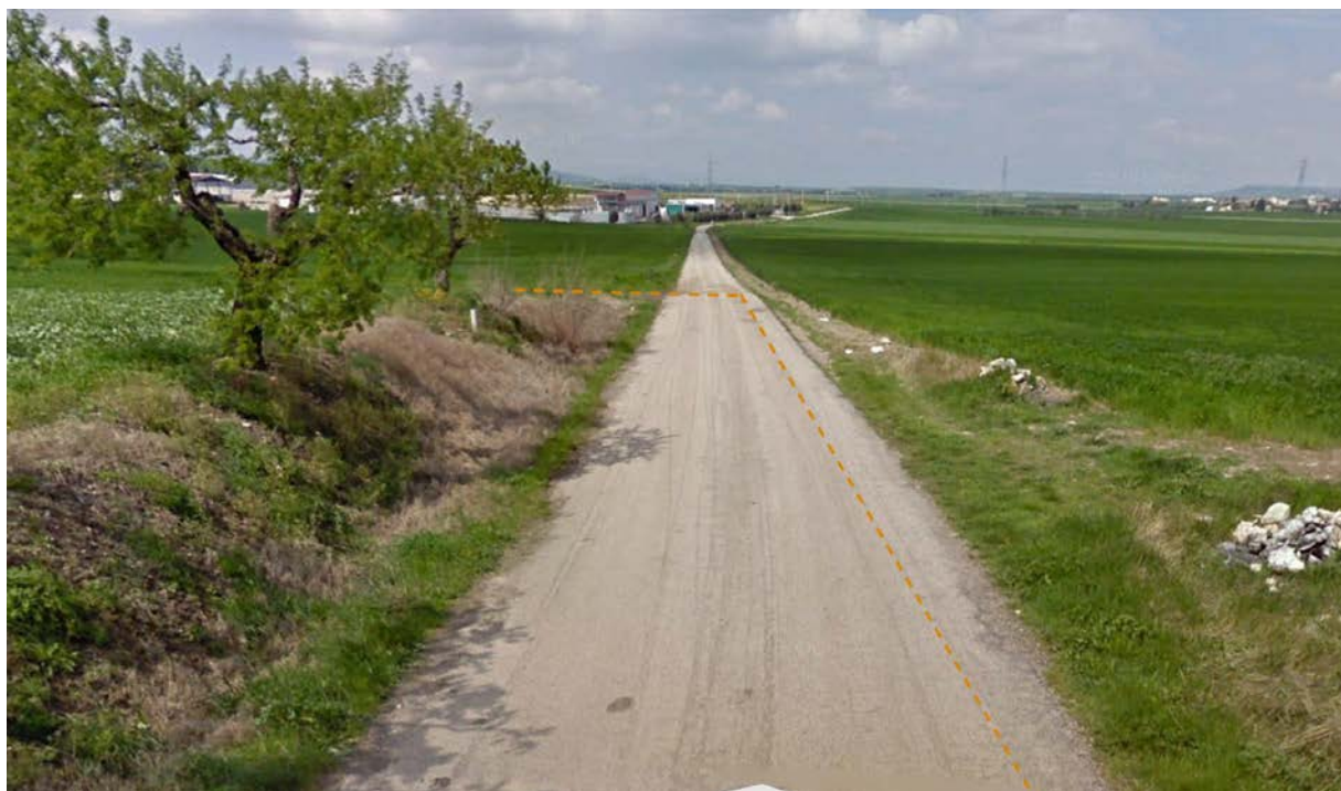
F. 3 Cavidotto su SP 104 in area sottoposta a Vincolo idrogeologico-Post Operam
