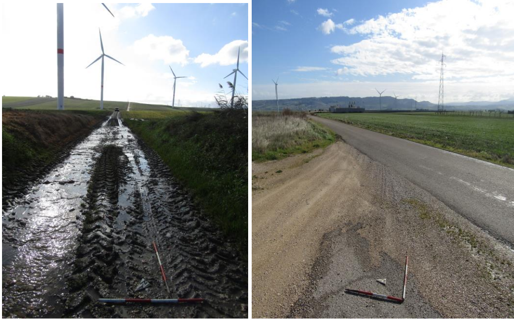
Tratto di raccordo tra la SP 104 e la Strada Comunale Ascoli-Deliceto
