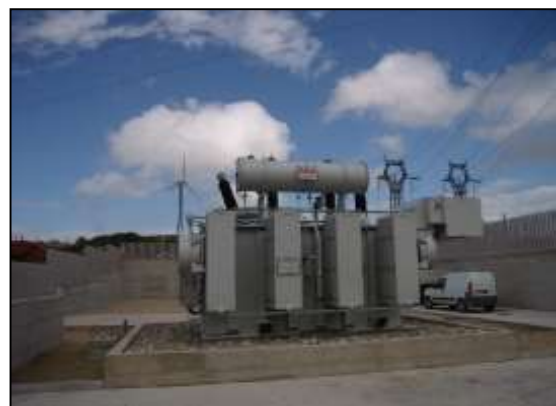
Figura 4-8 Trasformatore MT/AT
