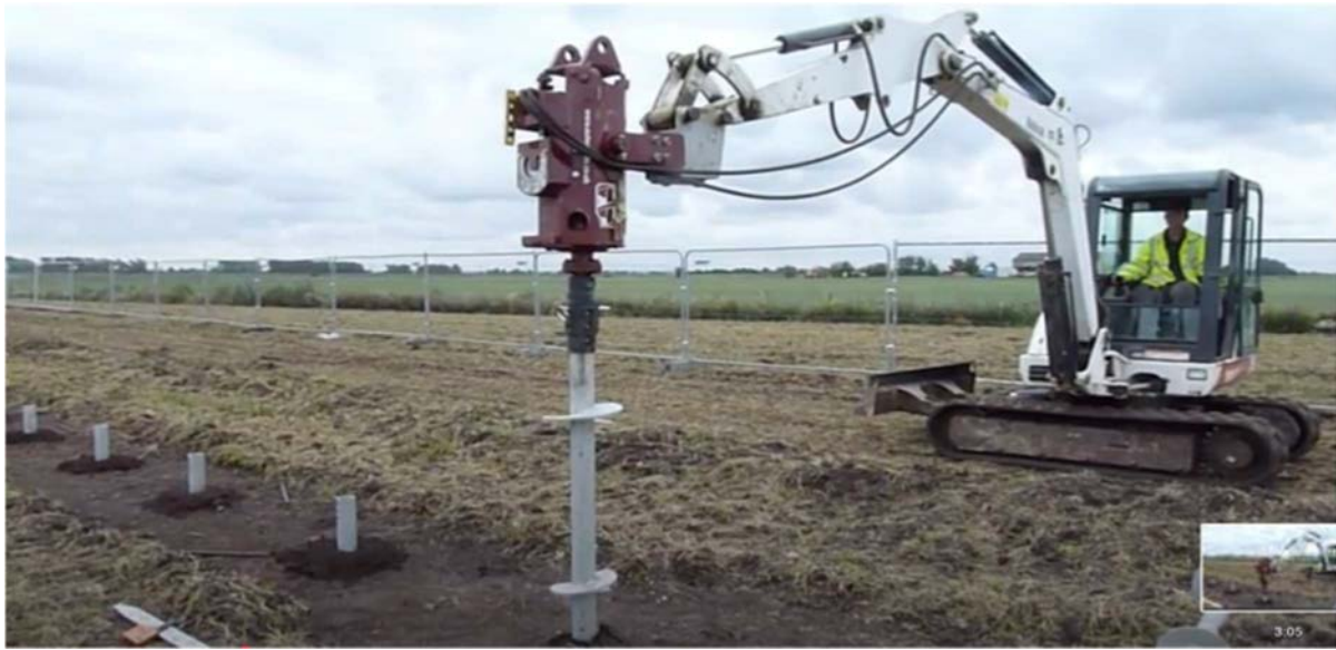
Figura 12-3 Macchina Operatrice per fissaggio supporti strutture
