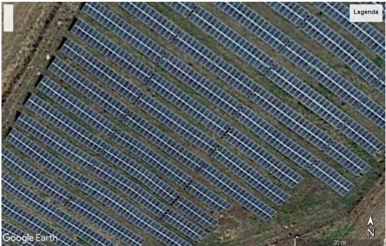
Esempio 3 da 20 metri di altezza - Molise
