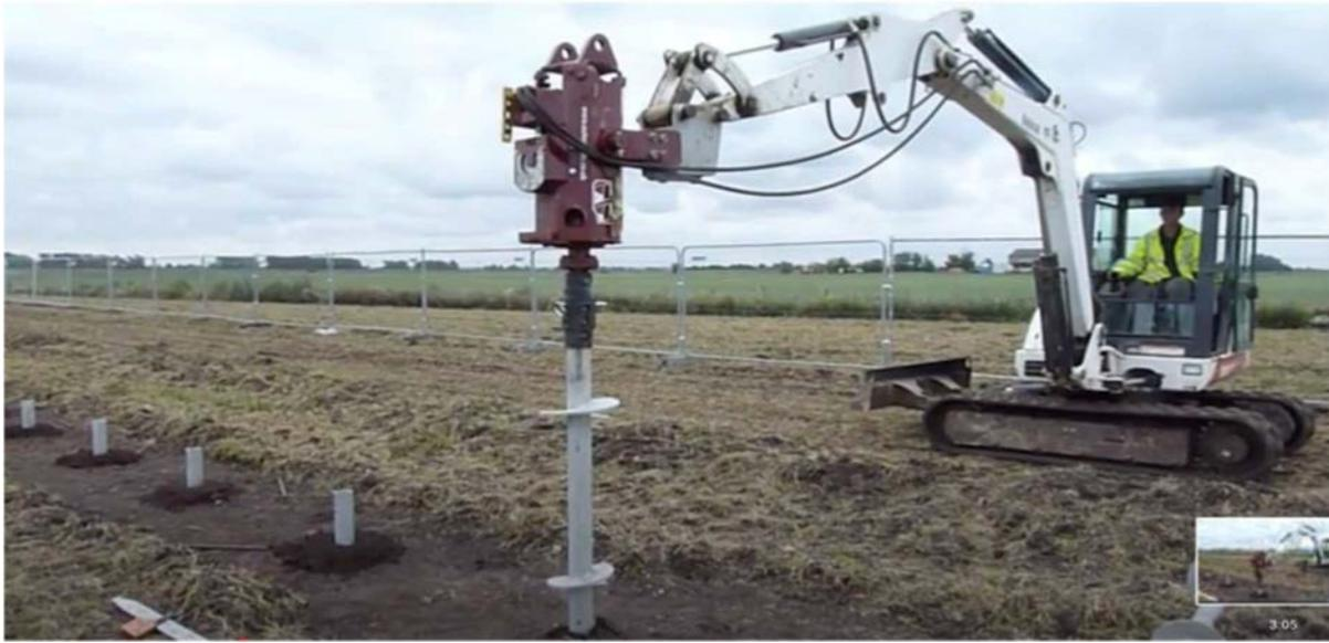
Figura 2-5 Macchina Operatrice per fissaggio supporti strutture
