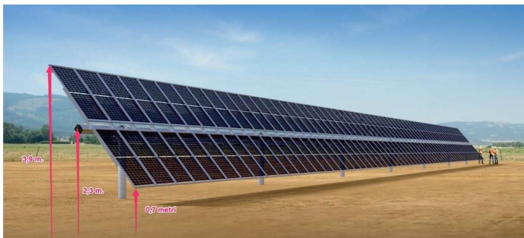
Figura 2-4 Inseguitore Mono-assiale NX Horizon Gemini- Rappresentazione struttura realizzata
