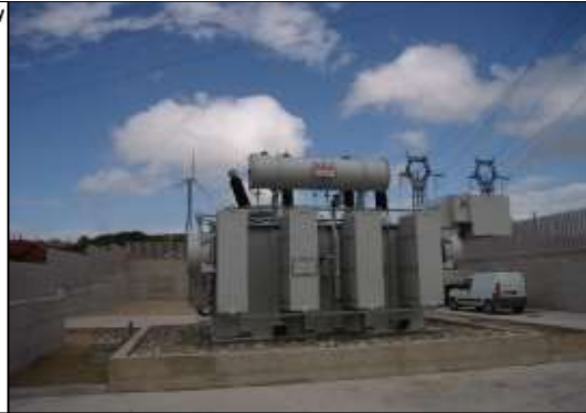
Figura 8-2 Trasformatore MT/AT
