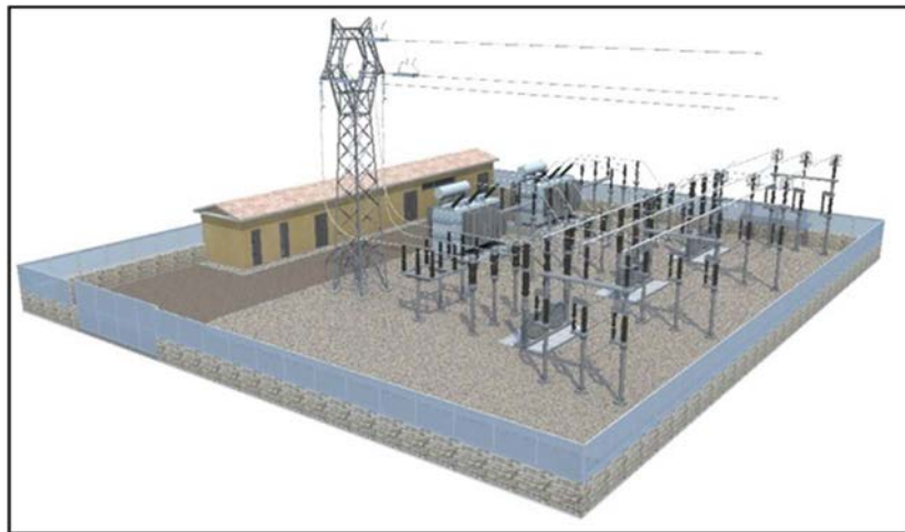
Figura 11-2 Sottostazione tipo con apparecchiatura ad alta tensione, trasformatore, quadri di media tensione e armadio di comando
