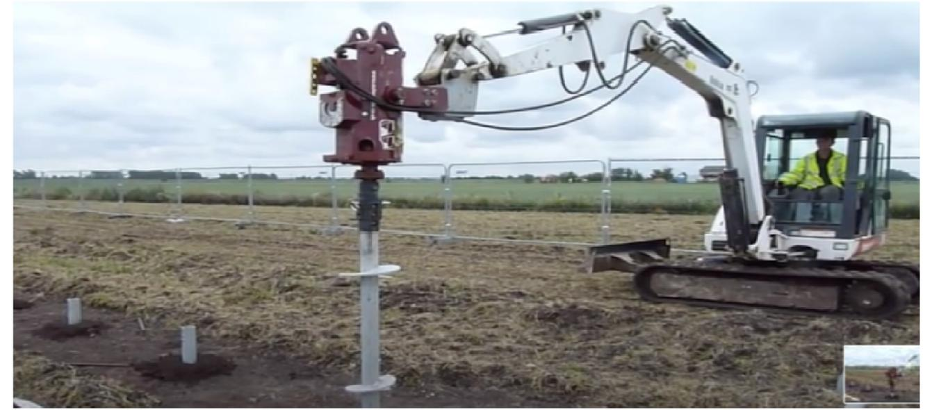
L'IMPIANTO DI PROGETTO - MACCHINA ESCAVATRICE PER IL FISSAGGIO DEI SUPPORTIDELLE STRUTTURE
