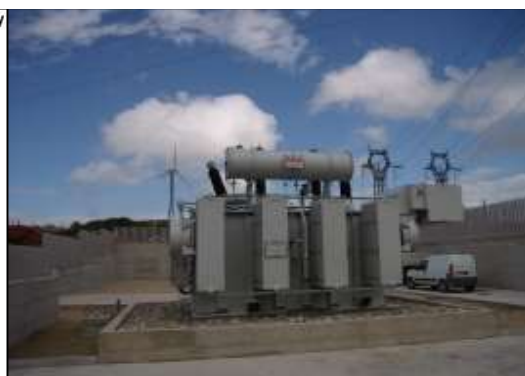
Trasformatore MT/AT
