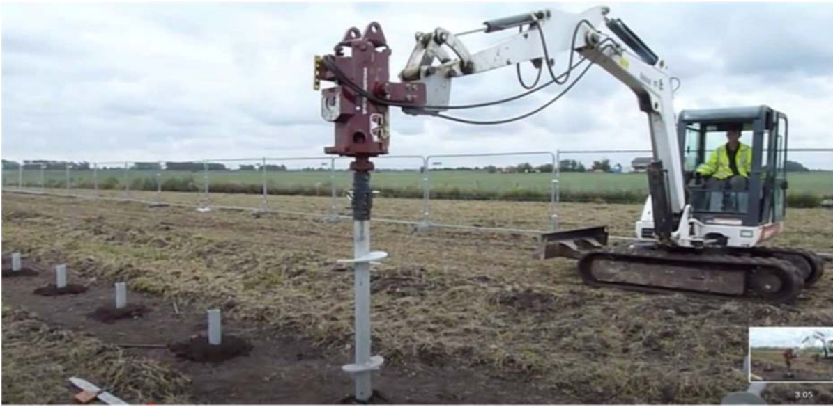
Figura 2-5 Macchina Operatrice per fissaggio supporti strutture
