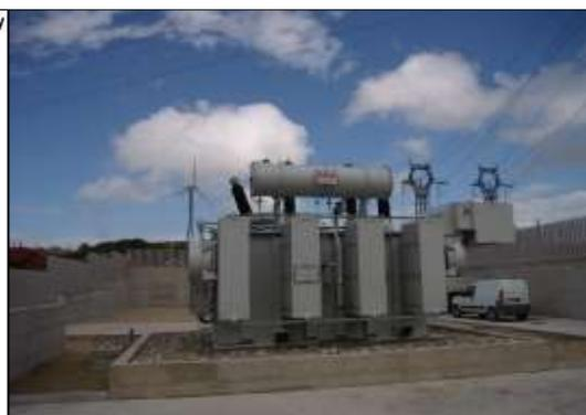
Figura 8-2 Trasformatore MT/AT
