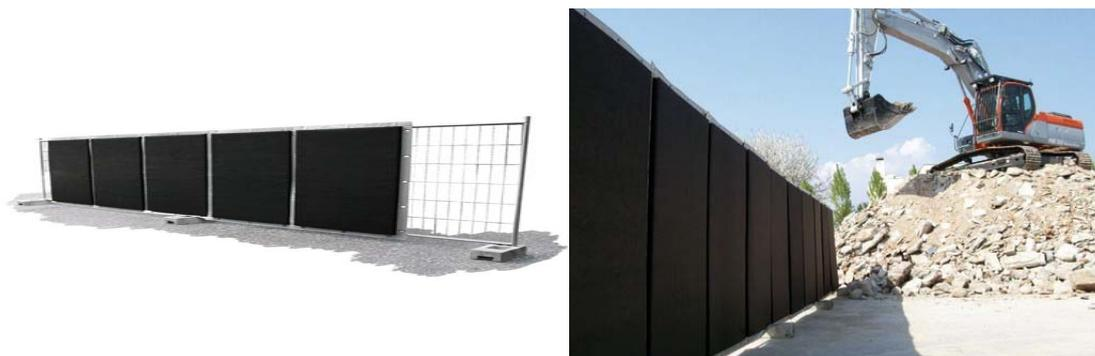
**Figura 3-38 Esempio di barriere mobili di tipo fonoassorbente.**
