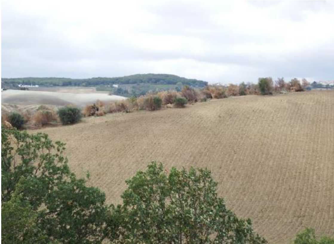
Foto 1 – Panoramica dell'area sud-ovest. Ripresa effettuata dalla diramazione della SS 483 che attraversa l'area d'impianto. In evidenza la matrice argillosa dei terreni. Sullo sfondo l'oliveto percorso da incendio che insiste sulla porzione sud dell'area.
