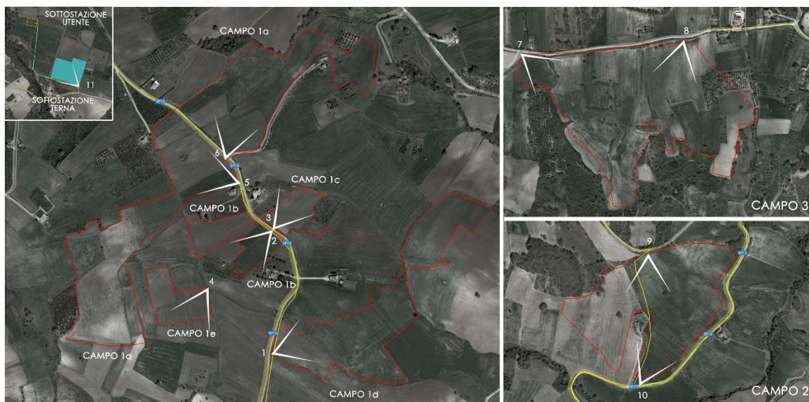
Figura 1: Vista aerea delle aree di impianto (Campo 1, Campo 2, Campo 3 e sottostazione utente e sottostazione Terna, con coni visivi).
