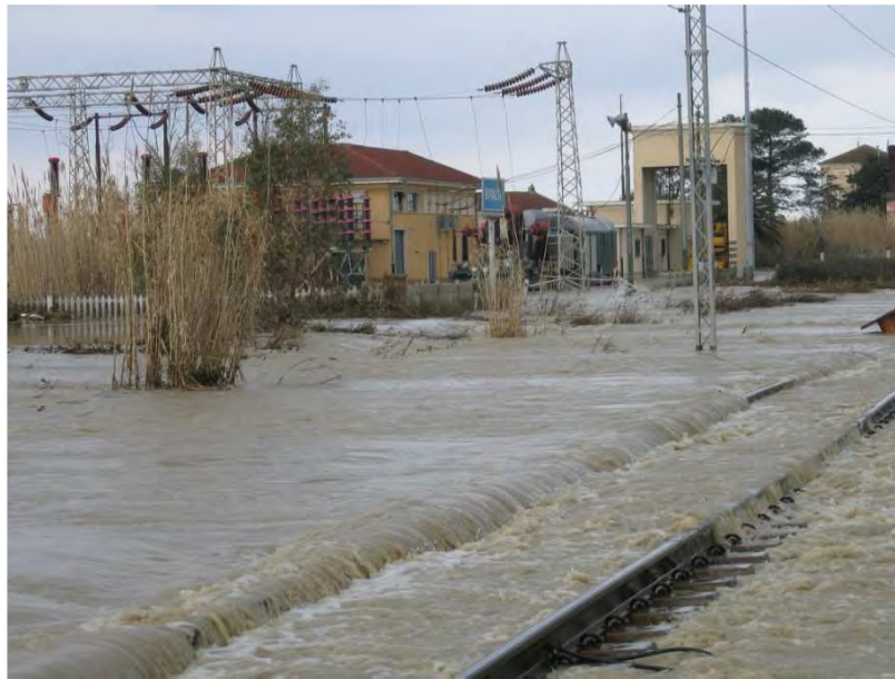
Figura 7. La ex stazione di Ripalta durante l' esondazione del Fortore. In basso a destra il binario sormontato dall'acqua
