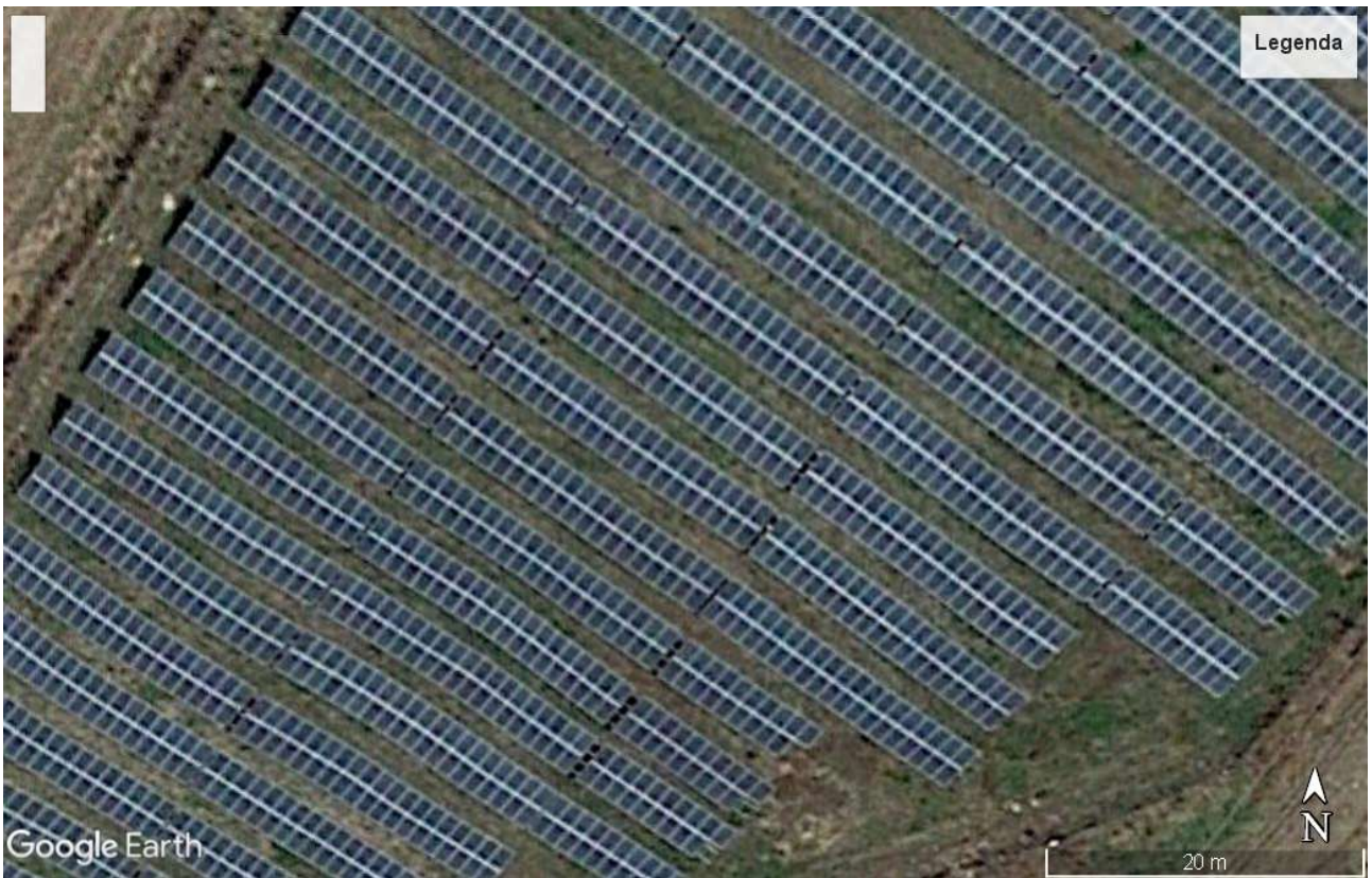
Esempio 3 da 20 metri di altezza - Molise
